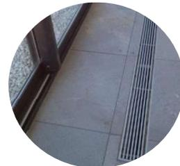
Las rejillas de ventilación: 0.013m. máximo de espaciamiento
