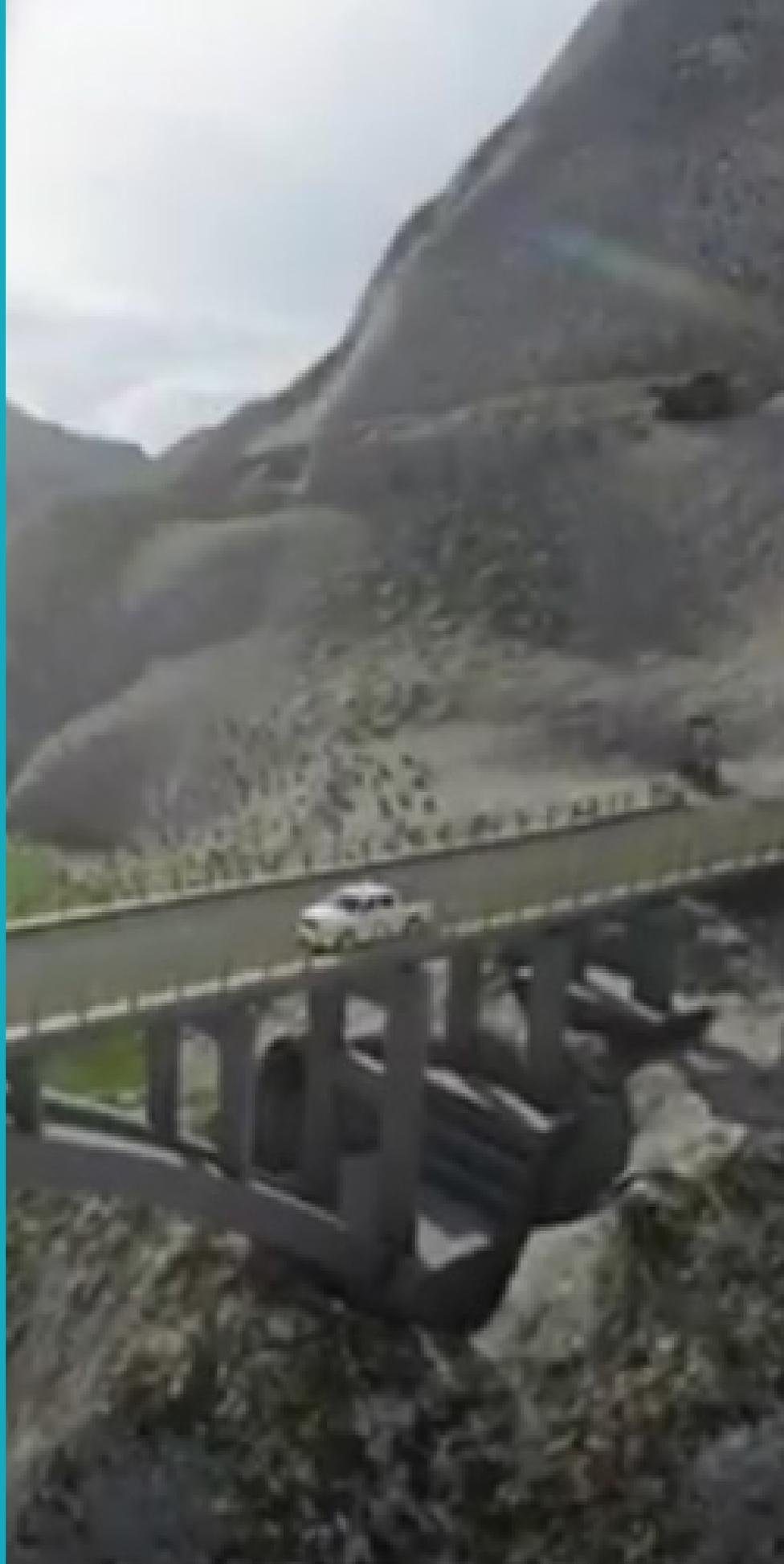
Puente vehicular interregional entre Huancavelica - Ayacucho. Con una longitud aproximada de 112 metros lineales, de tipo reticulado, sobrecarga HL 93 y de doble vía (7.20 metros lineales).
