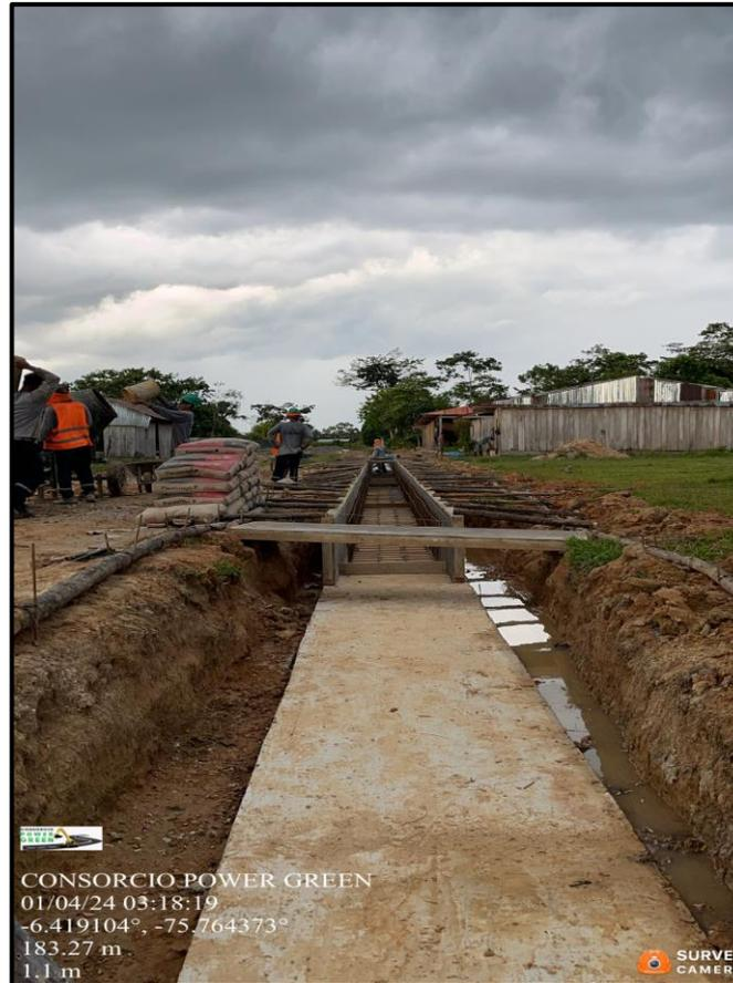
*Encofrado y armado de losa (piso) en tramo de colector 02
