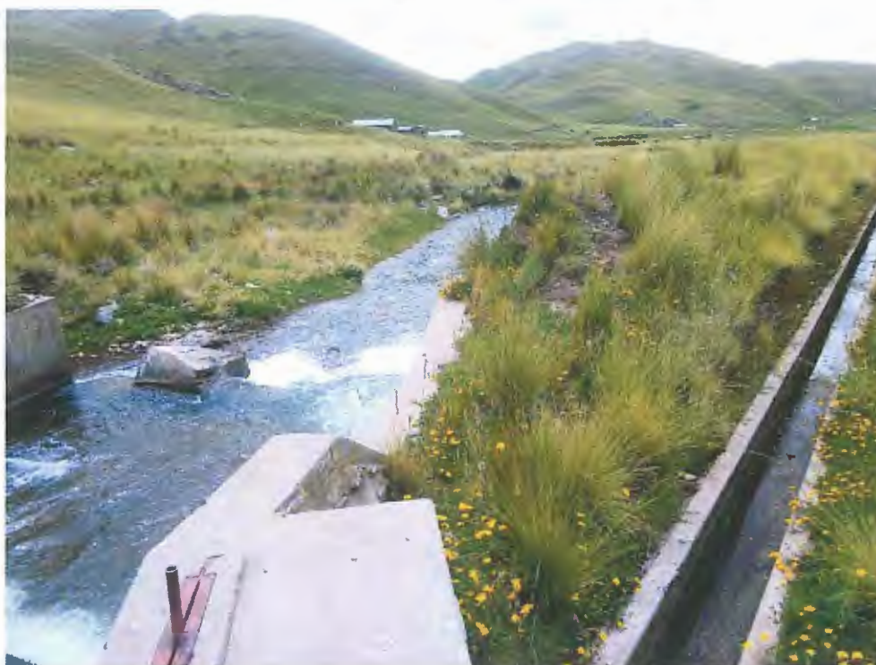
Foto 03: Estructura actual de captación bocatoma aguas abajo.
