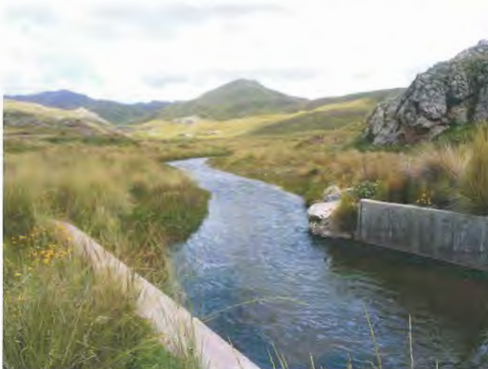
Foto 04: Vista de estructura actual de captación bocatoma aguas arriba.
