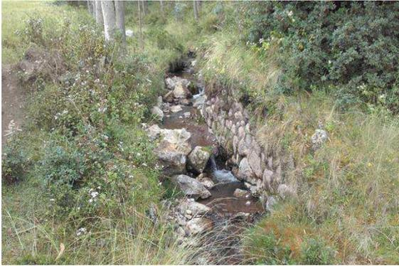
**Foto N° 104:** Sistema de canalización pre hispánica en estado de deterioro por socavación - micro cuenca Cachimayo.
