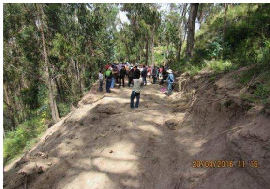
**Fotos N° 106 y 107:** Apertura de una trocha carrozable ejecutada por una maquinaria pesada ocasionando la destrucción del camino prehispánico; Comunidad Senqa Quespehuara. (Abril, 2016).
