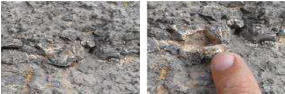
**Foto N° 155 y 156:** Procesos de micro fracturas en Baluartes pétreo 8 tramo 44.
