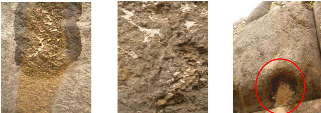
**Foto N° 157,158 y 159:** Sitio Baluartes, costras de colores, acumulación de sólidos en suspensión (Polvo fino y mediano) arrastrados por el agua en la superficie del elemento pétreo N°1 tramo 40 (a), Costras de sales blancas del pétreo N°9 tramo 41 (b), y Costras marrones producto de la disolución química pétreo N°18 tramo 38 (c).
