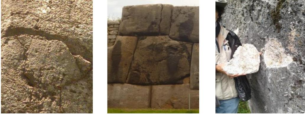
**Foto N° 152, 153 y 154:** Fisuras de diferente tamaño e intensidad en Baluartes pétreo N°16 tramo 30 (a); filtración de agua después de 2 horas de lluvia en tramo 42 (c), Desplazamiento en Baluartes pétreo N°7 tramo 35 (b); fracturas en Baluartes pétreo 8 tramo 44 (e).
