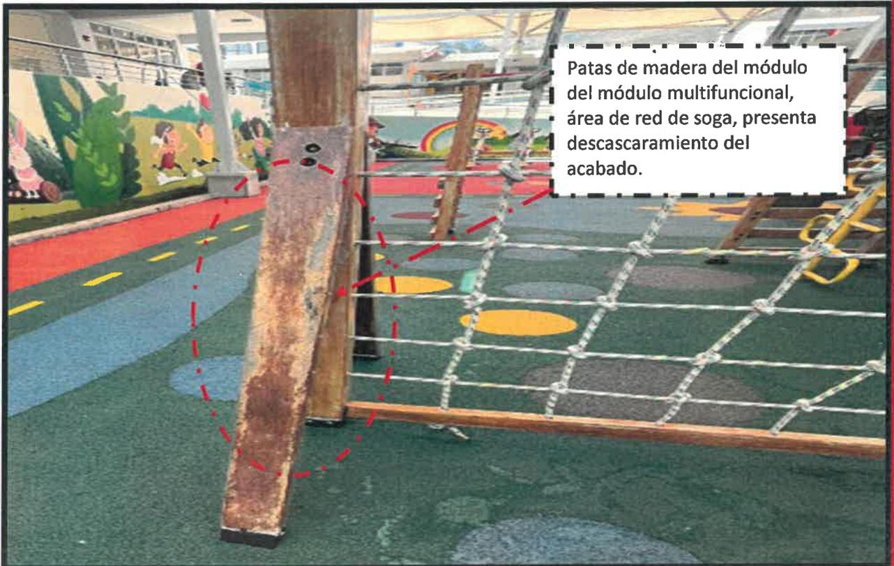
**Imagen 09:** módulo de juegos multifuncional de la red de soga se advierte descascaramiento en el acabado.
