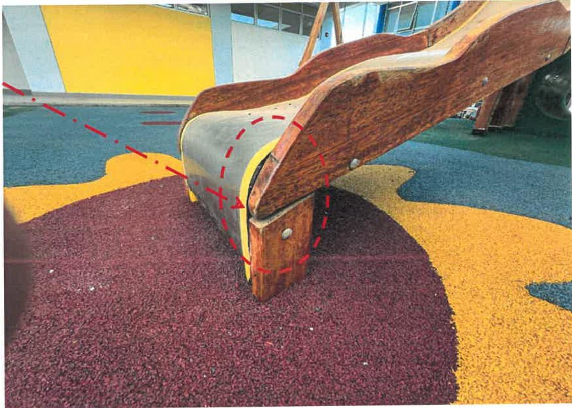
Imagen 21: se observa en el módulo multifuncional de la resbaladora, separación de las piezas, no se ha determinado si es a causa del desarmado o fueran las condiciones en que se entregó el bien por el contratista.
