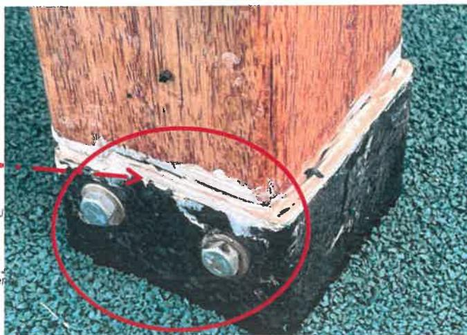
**Imagen 18:** se observa un deficiente acabado en la pata de madera del módulo multifuncional de juegos, no se ha determinado si se debe al desmontaje o fue el estado de la entrega por el contratista.
