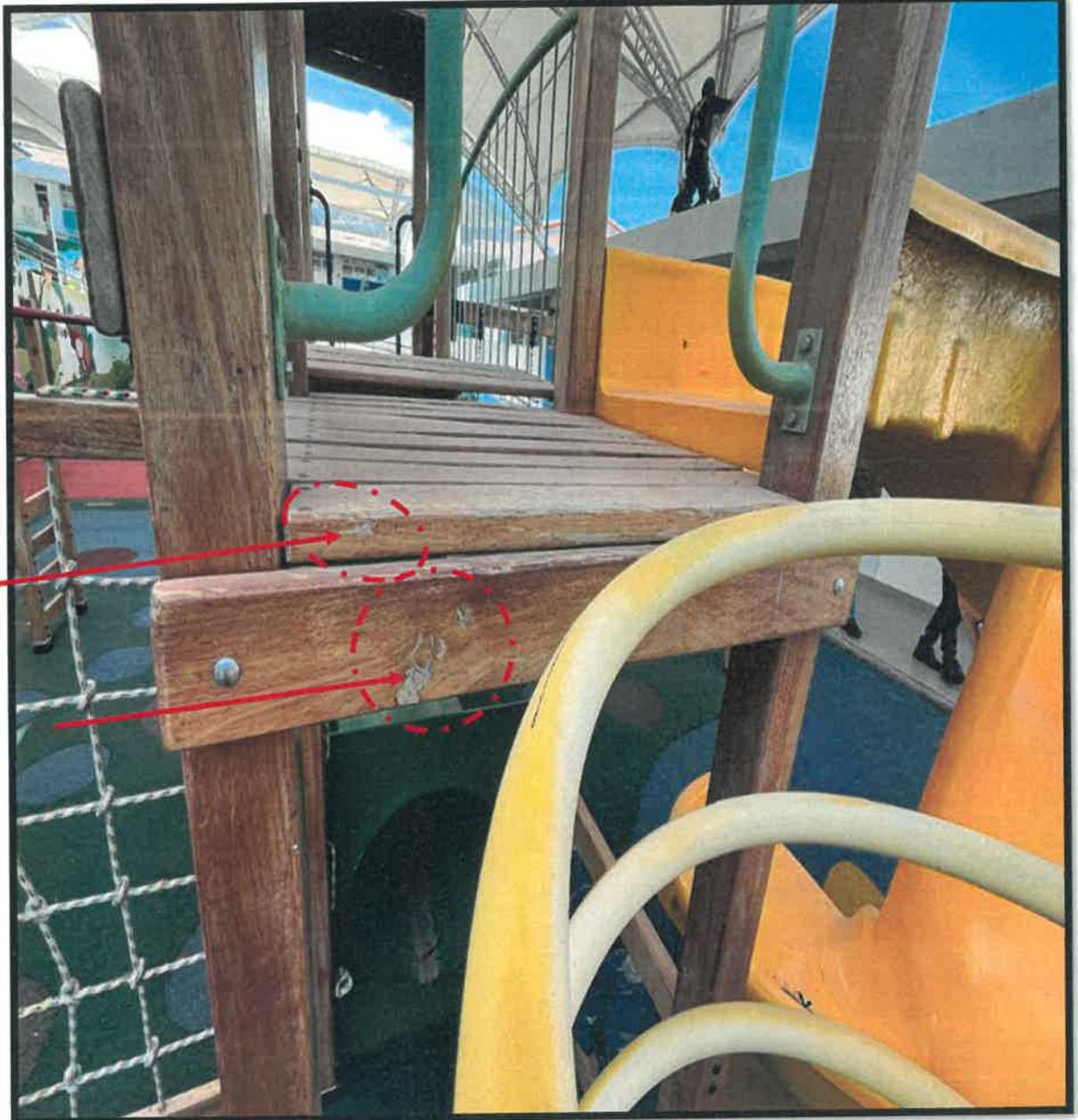
Imagen 17: se observa lo que sería una imperfección en la madera del módulo de multifuncional.
