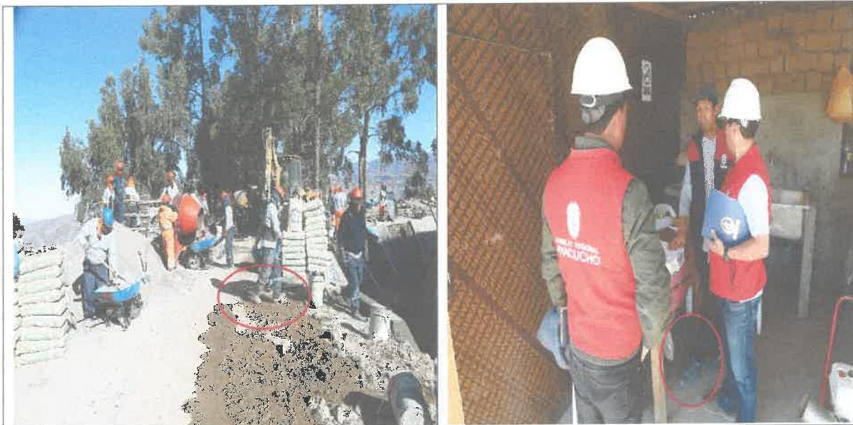
**IMG. 10.- Uso de zapatos de seguridad inapropiados, no cuentan con la seguridad requerida deben responder a las condiciones existentes del lugar de trabajo.**
