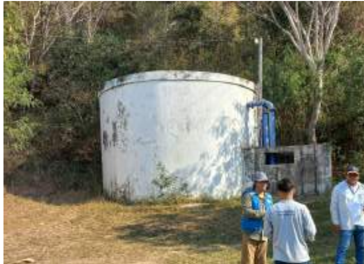
Imagen N° 78: Reservorio R90 - Localidad Picota
