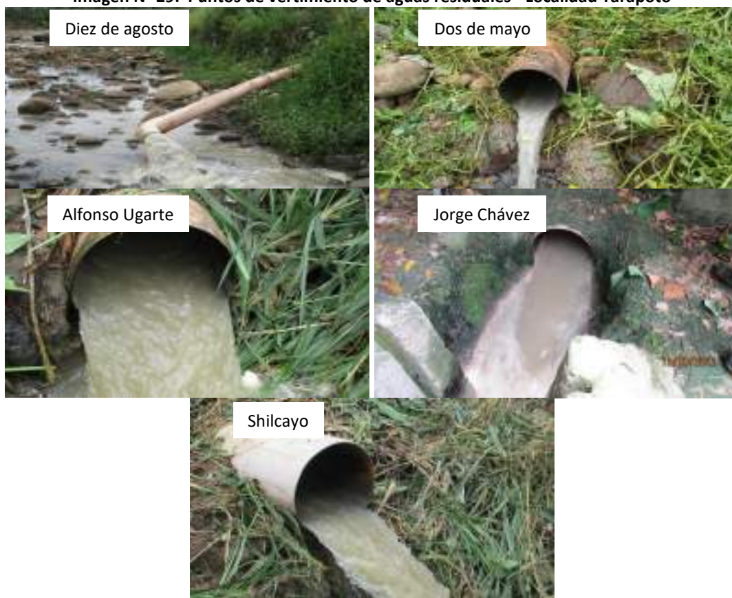
Imagen N° 29: Puntos de vertimiento de aguas residuales - Localidad Tarapoto
