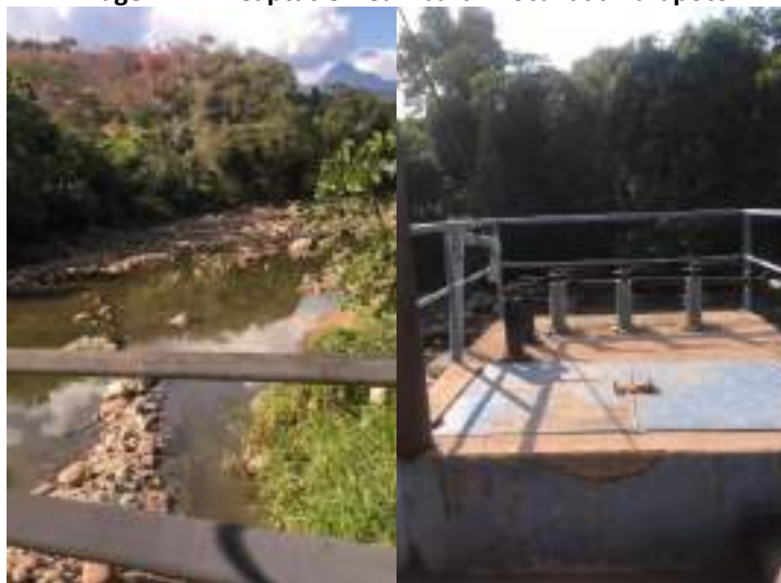
Imagen N° 7: Captación Cumbaza - Localidad Tarapoto
