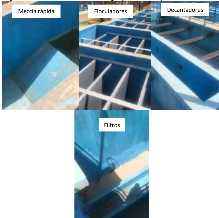
Imagen N° 17: Planta de tratamiento de agua potable: Cachiyacu 1 - Localidad Tarapoto
