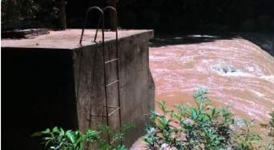
Imagen N° 31: Captación - Localidad Saposoa
