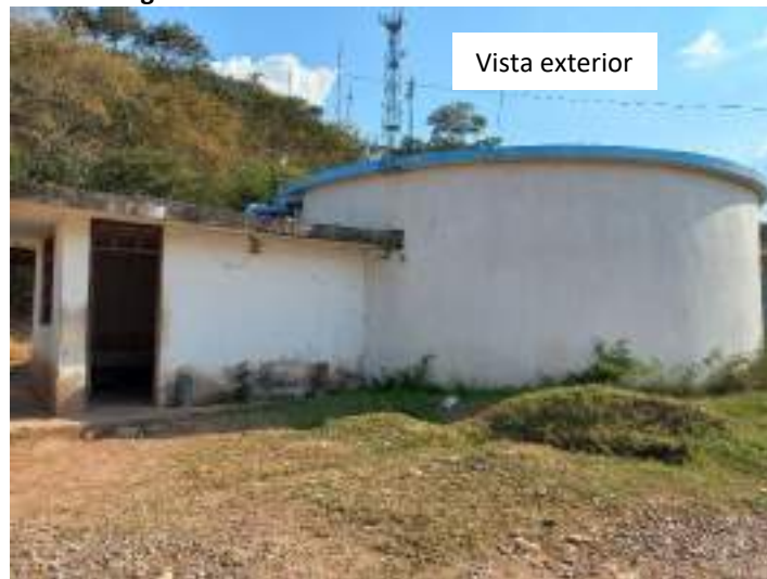
Imagen N° 80: Reservorio R350 - Localidad Picota
