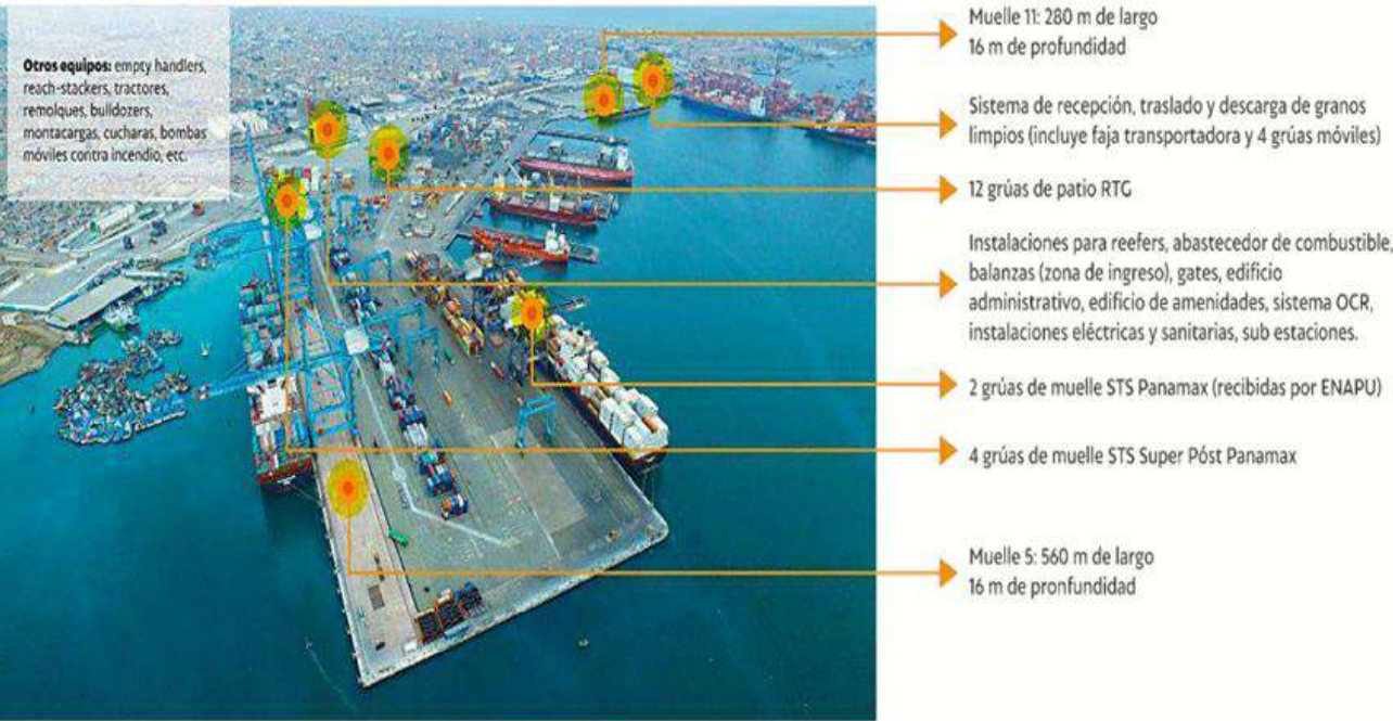
Figura 84. Infraestructura del Terminal APM Terminals
