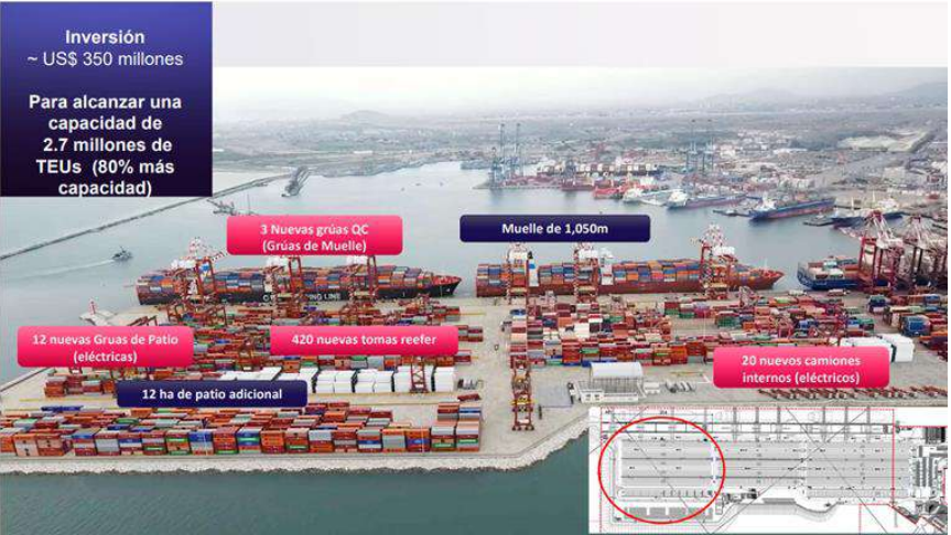
Figura 82. Infraestructura del Terminal Muelle Sur
