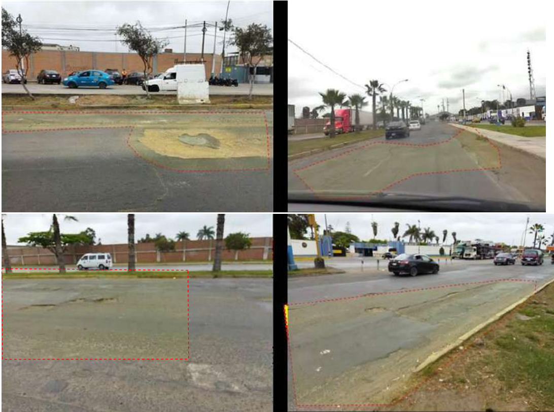
Figura 88. Estado de conservación Tramo Av. Bocanegra-E. Faucett - Ovalo 200 Millas
