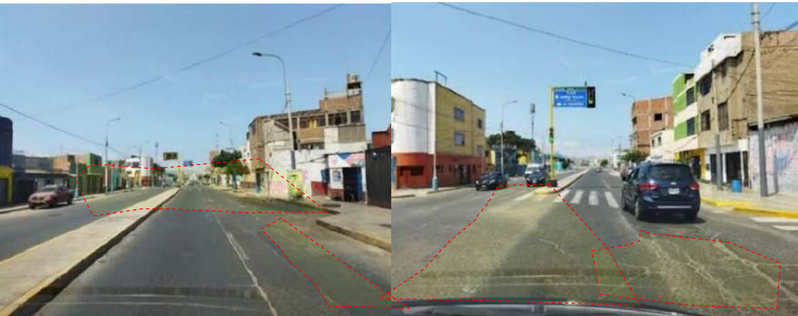
Estado de conservación Tramo: Av. José Gálvez Tramo Av. Colina con Jr. Grau
