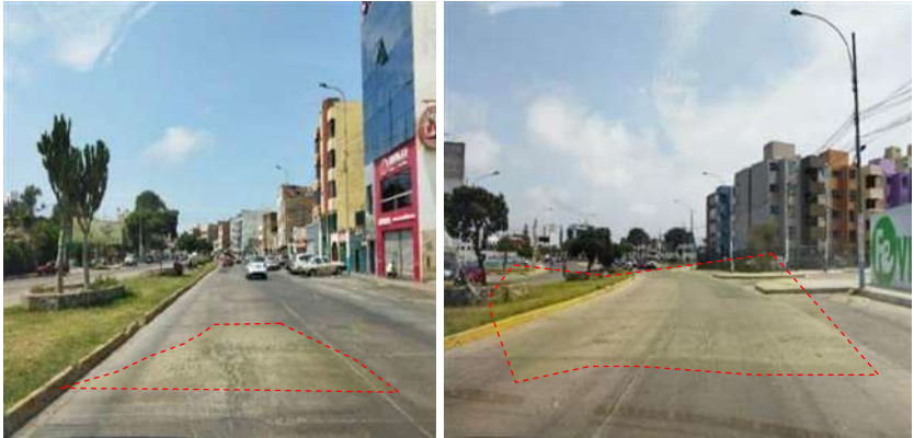
Figura 87. Estado de conservación Av. Haya de la Torre: Tramo Av. La Libertad – Av. Pacífico
