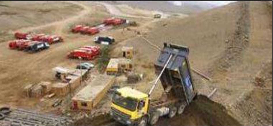
Figura 53. Relleno Sanitario Modelo del Callao
