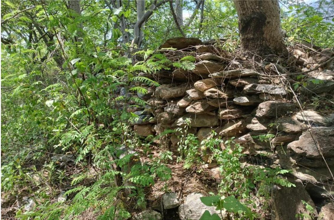
*Foto 7. Vista de muro en proceso de destrucción por la vegetación intrusiva.*
