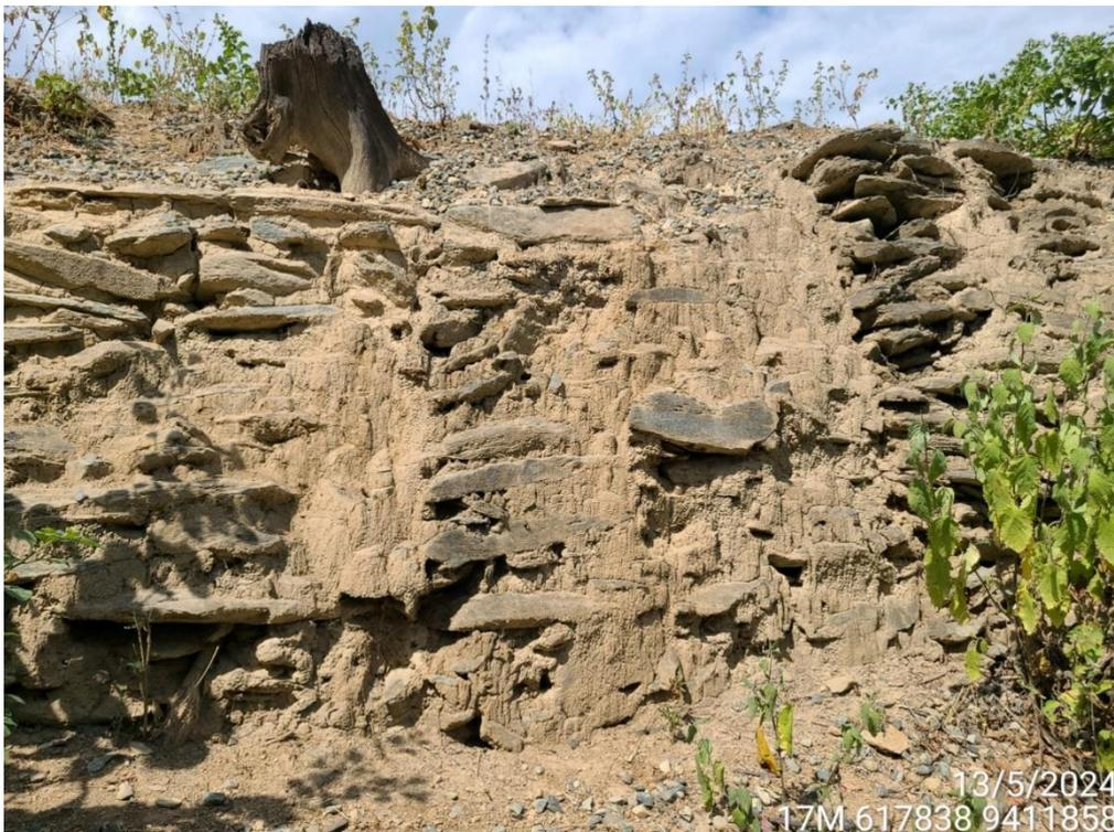
*Foto. 9 Se visualiza la técnica constructiva del paramento del muro, compuesta por lajas de piedra y unidos por argamasa de barro y pachillas.*
