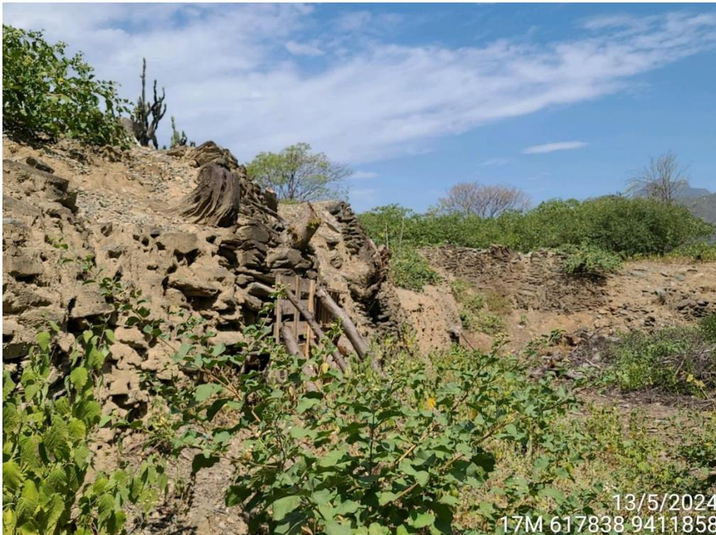
*Foto 8. Vista lateral donde se puede visualizar la conservación preventiva de uno de los muros, con parrillas de madera y troncos para evitar el colapso de los muros.*
