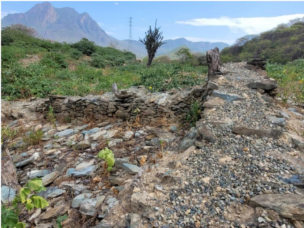
*Foto. 12 Se visualiza la cabecera de los muros con agregado de gravilla para evitar su deterioro.*
