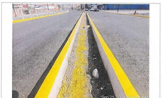
Pintado de sardineles con pintura de tráfico en berma y costados, prog. 6+180 - 6+870.
