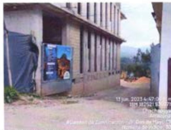
Imagen N°06 - Predio Vecino ubicado en Jr. Dos de Mayo Cdra.014, Sector 07, Mz.037, Lote 002, con uso actual de Deposito de Materiales de construcción
