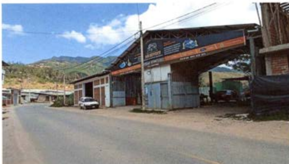
IMAGEN 13: VISTA DE LAVADERO DE VEHICULOS
