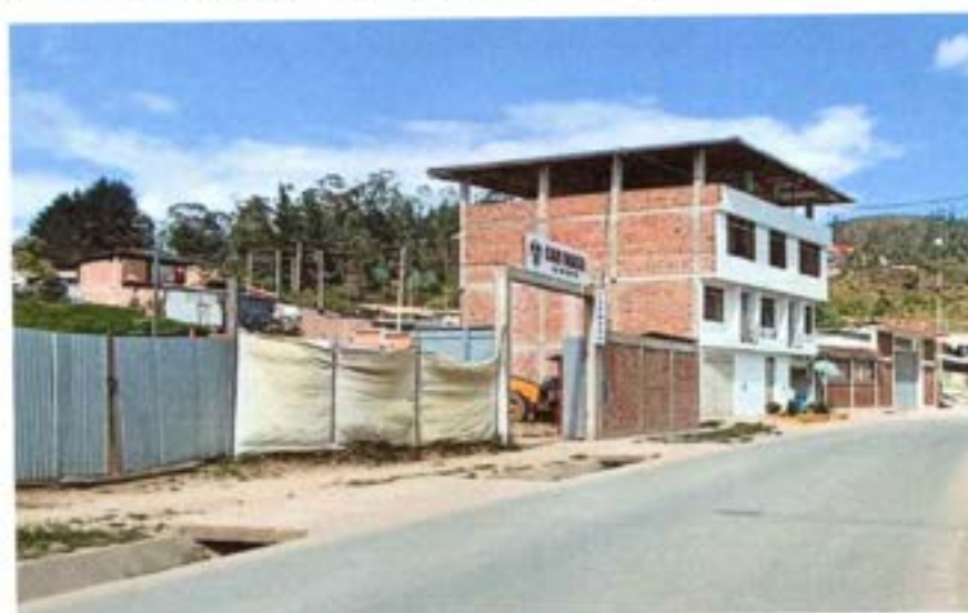
IMAGEN 9: VISTA DE LAVADERO DE VEHICULOS
