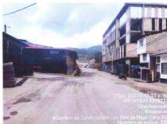
Imagen N°01 - Predio ubicado en el Jr. Dos de Mayo Cdra.014, Sector 07, Mz.053, Lote 008.
