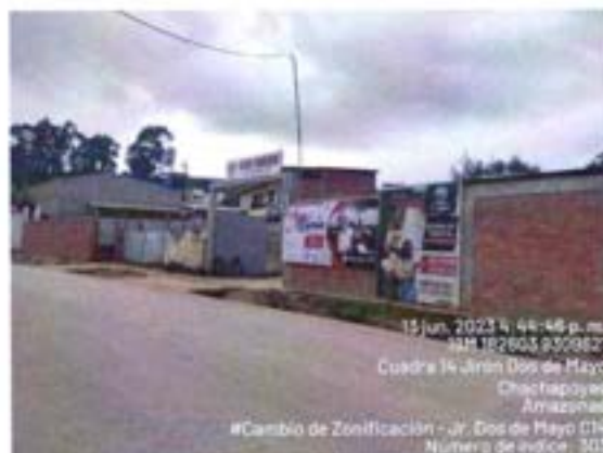
Imagen N°04 - Predio Vecino ubicado en Jr. Dos de Mayo Cdra.014, Sector 07, Mz.052, Lote 005, con uso actual de Carwash – "Aqua Express"
