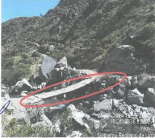
Se puede observar que el tablero de rodadura es de tabloncillos de madera y se soporta en estribos de piedra, no cumple con los estándares del manual de puentes.
