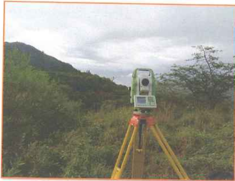
Instalación de la estación leica ts 03
