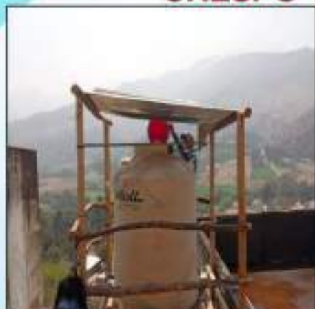
SE REALIZO LA INSTALACIÓN DEL SISTEMA DE CLORACIÓN DE AYANCOCHA.
