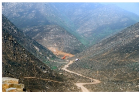
Foto 2. Vista panorámica del área de las lomas de Manchay donde se encuentra intervenida por el contratista Pórtland parte de la Cementera CEMENTOS LIMA.
