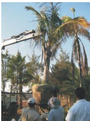
Fig. 4. Izaje de palmera capada mediante el uso de brazo mecánico de grúa telescópica.
