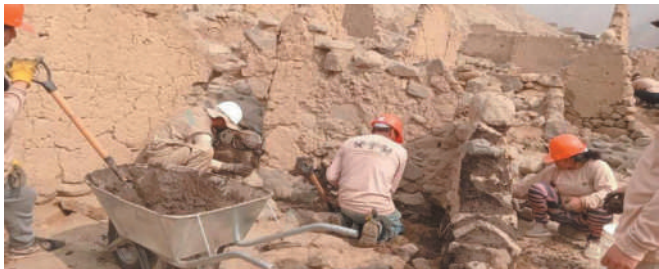
Río Seco o Huaycán Alto. Calzaduras y protección de cabeceras, Lima
