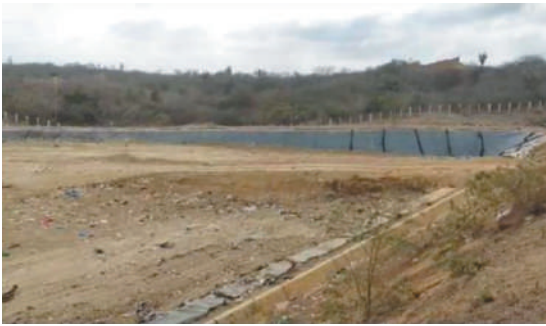
Asistencia técnica en la operatividad de rellenos sanitarios y áreas degradadas por residuos sólidos en ámbitos por nivel de susceptibilidad por el FEN - MINAM
