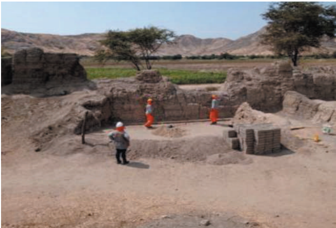
Trabajo parcial de conservación (protección de muros), unidad 01, Tambo de Pósope, Lambayeque
