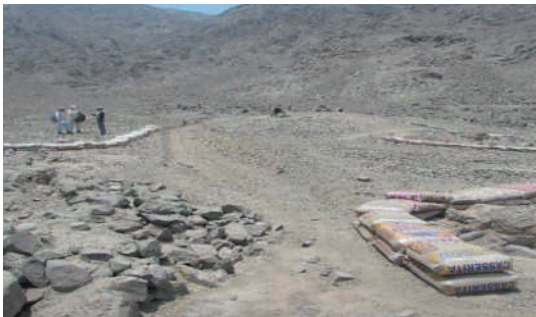
Carapongo B. Protección con costales rellenos con arena, Lima.
