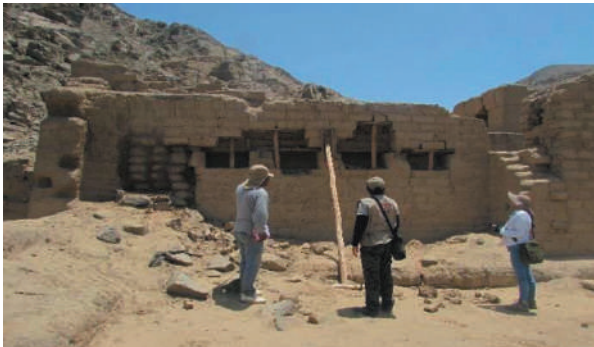
Uquira. Apuntalamiento de hornacinas de muro de adobes, Lima
