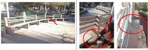
**Descripción:** Se aprecia el estado de las bancas de concreto, evidenciando que las frías de madera, no se encuentran adecuadamente ancladas a la estructura de concreto, no cuentan con tratamiento de protección y acabado.
