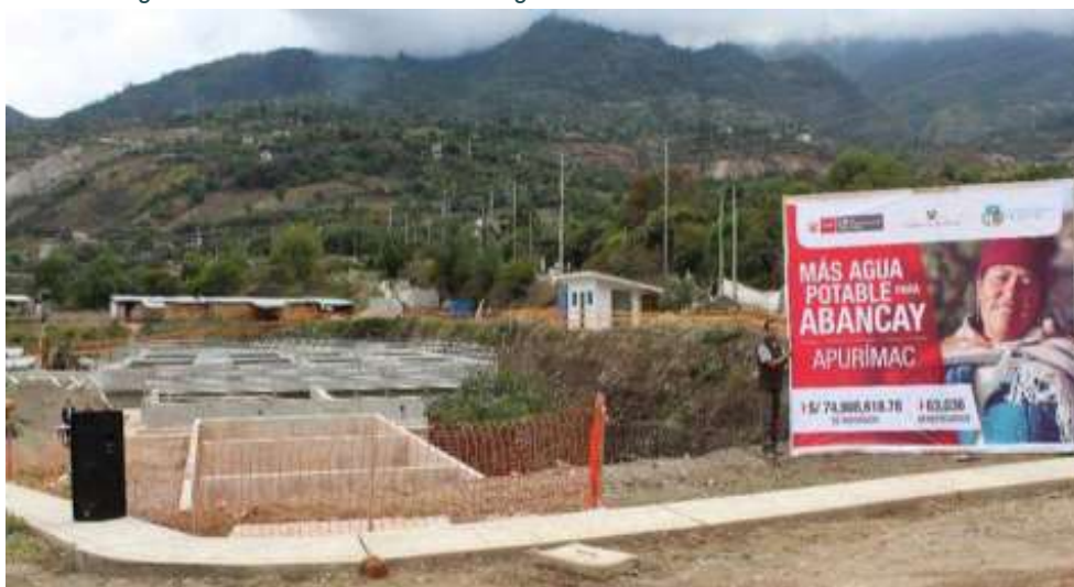
Imagen 18: Obra en construcción laguna de oxidación EMUSAP - ABANCAY
