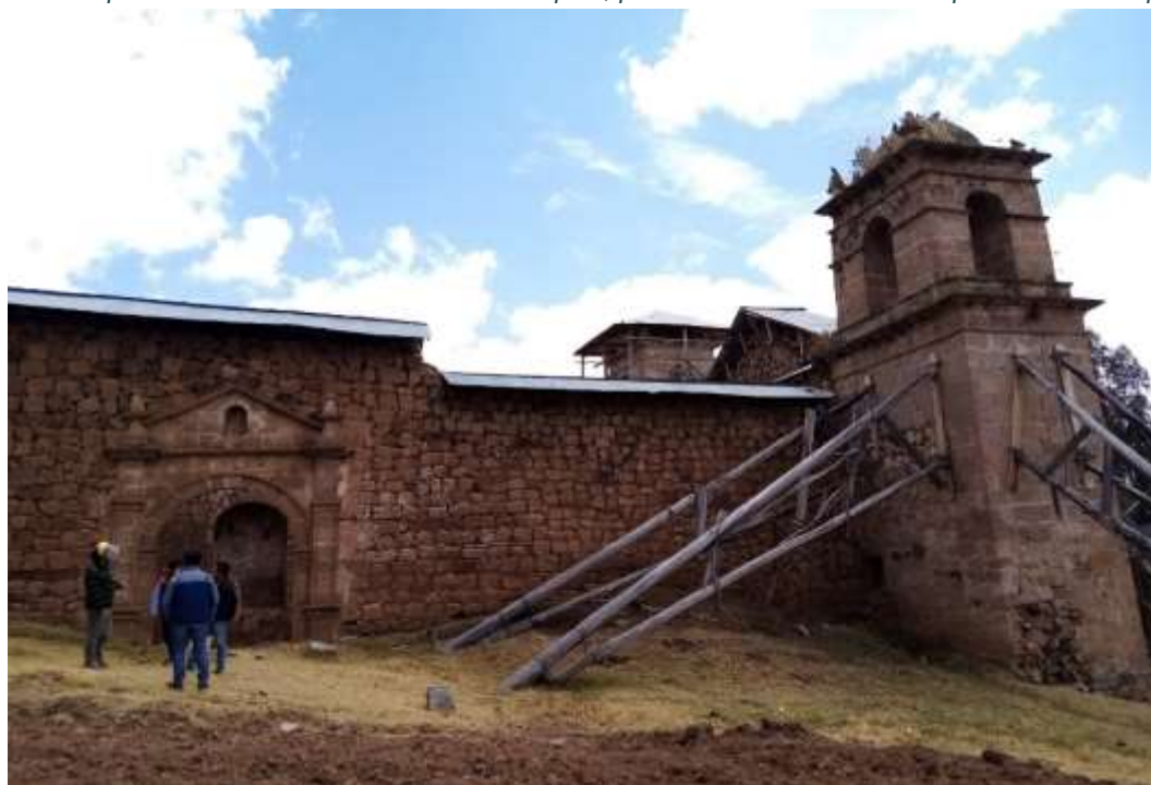
Imagen 4: Templo San Sebastián en el distrito de Haquira, provincia de Cotabambas departamento de Apurímac
