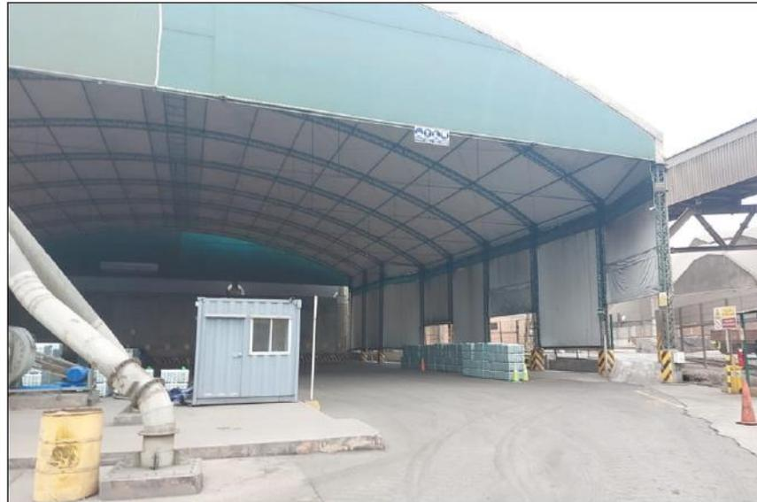
La estructura tipo hangar comprende una extensión de aproximadamente 2 500 m<sup>2</sup>, conformada por columnas de celosía apoyadas sobre zapatas de concreto.
