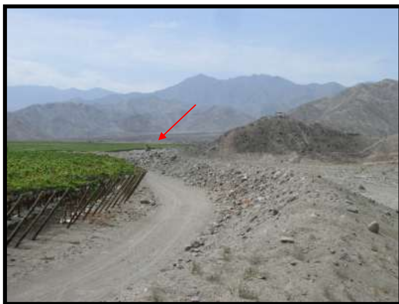
Foto 06. La flecha en color rojo indica la ubicación de la maquinaria pesada realizando trabajos de remoción en el sector B.
