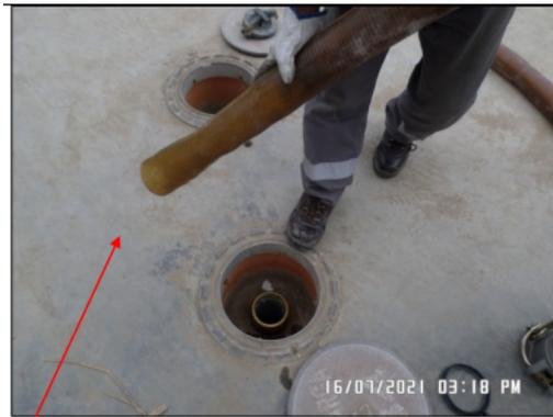
En el extremo de la manguera que va a conectarse al tanque de Almacenamiento no tenía el acople que asegura la hermeticidad al momento de descargar el combustible
