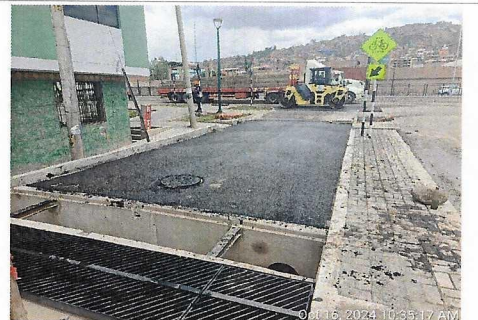
Pavimentado primera capa en bocacalle, prog. 4+580.
