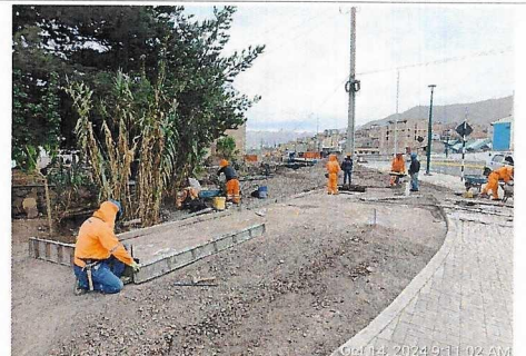
Apertura de trabajos de encofrado en minigimnasio en Puente Costanera II, prog. 6+120.
