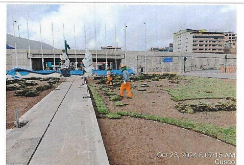
Trabajos de champeado en Óvalo Versailles, prog. 6+880.
