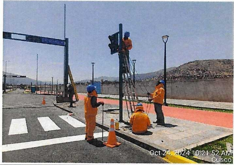
Trabajos de cableado en postes de semáforo en Óvalo, prog. 3+600.
