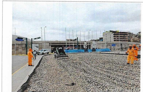
Trabajos de movimiento de tierras para champeado en área verde en Óvalo Versailles, prog. 6+880.
