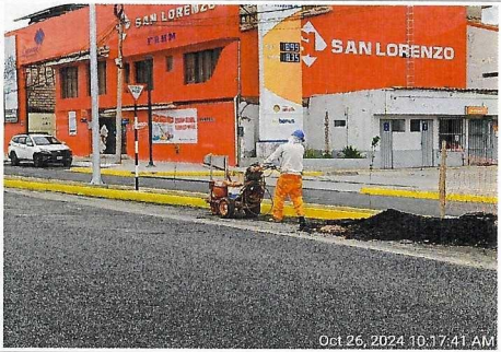
Pintado de sardineles, berma central y lateral en Av. Colombia, prog. 1+000.
