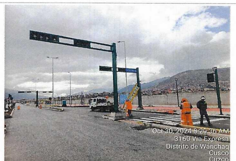
Trabajos de semáforos, prog. 3+600 ambos lados.
