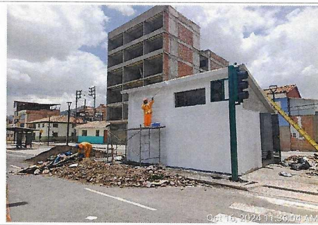
Pintado de exterior de Subestación Eléctrica con imprimante, prog. 5+880.
