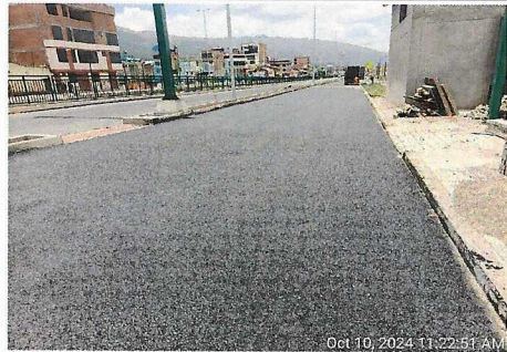
Pavimentado de MAD en vía auxiliar, prog. 3+270 - 3+310.
