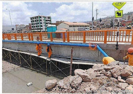
Adosamiento de tubería de agua en Puente Costanera I, prog. 4+360 - 4+400.
