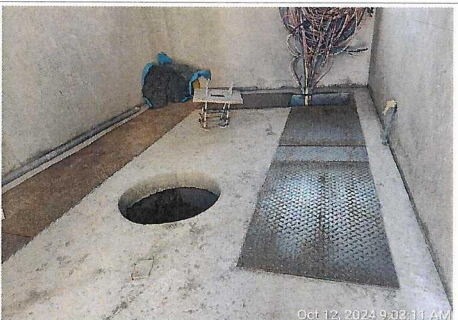
Recubrimiento metálico de canal eléctrico en Subestación Eléctrica, prog. 5+200.
