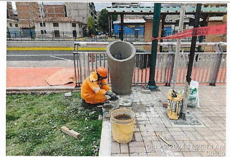
Trabajos en bebederos en minigimnasio, prog. 5+530.
