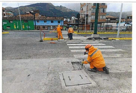
Trabajos de empalme en cajas de semáforos, prog. 5+870.
