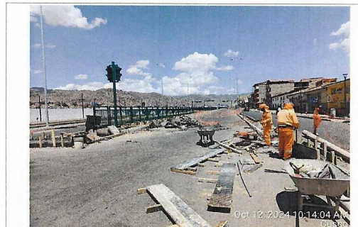
Trabajos en sardineles en pasos peatonales en Óvalo Tomás Tuyo Túpac.
