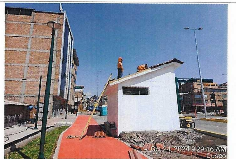
Trabajos de cobertura de teja en techo de Subestación Eléctrica, prog. 5+200.
