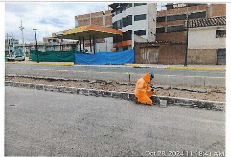
Reparación de sardineles de separador lateral, prog. 3+450.
