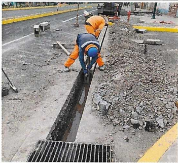
Trabajos de drenaje con monoblocks en bocacalle, prog. 5+910.
