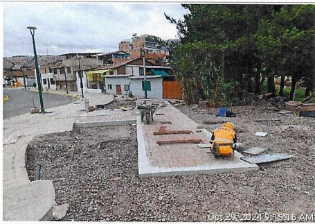
Trabajos para colocación de minigimnasio en Puente Costanera II, prog. 6+110.
