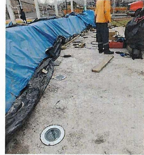
Trabajos de instalaciones de luminaria ornamental en monumento nodo Versalles, prog. 6+880.
