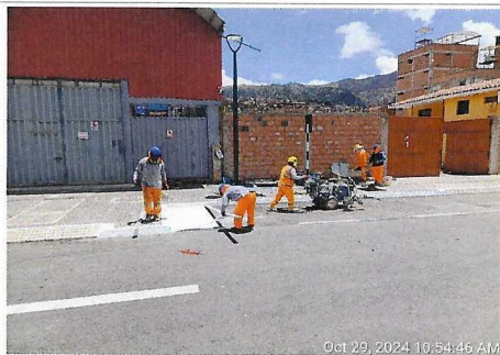
Trabajos de pintado en playa de estacionamiento, prog. 4+070.
