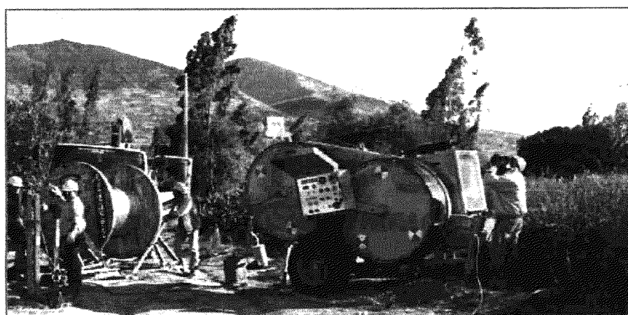
Figura 21. Tendido de cable OPGW con tensión controlada
