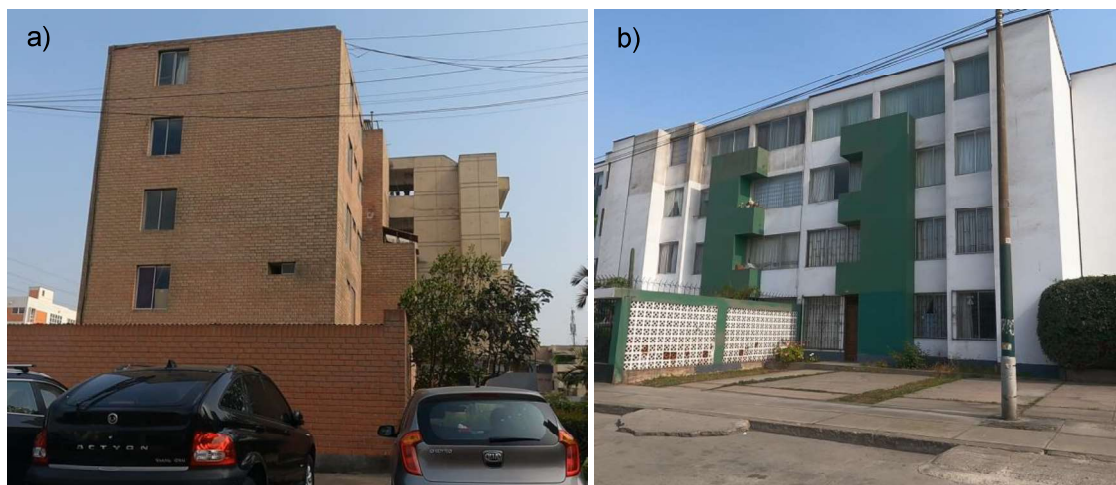
Figura 18 a) Foto de una estructura típica en la manzana B. b) Foto de una estructura típica en la manzana D.
