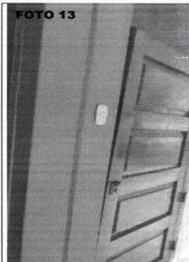
Foto 13: El 1 de marzo del 2024 tomé evidencia de la puerta del aula de 4° grado, encontrándola descolgada, las bisagras estaban desprendidas en la parte superior, impidiendo cerrarla.
