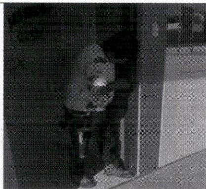
Puerta del aula de 1° y 2° grado reparada por el Sr. Williams Gomero, el 12 de marzo del 2024, la puerta ya abre y cierra correctamente con las 3 vueltas de chapa, se realizó trabajo de limadura en donde encaja la cerradura de la chapa.
