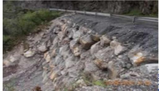
Vista de Recuperación del talud inferior con enrocado
