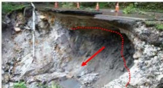
Vista de talud inferior, asentamiento, erosión y derrumbe.
