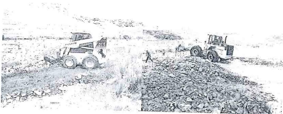
Minicargador y cargador frontal apoyando en el encauzamiento de la quebrada de Tayataya.
