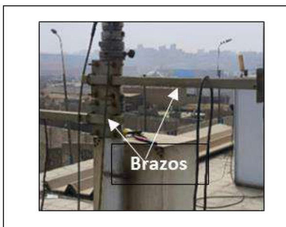
Figura 9. Instalación de los sensores de Temperatura y Humedad Relativa (Termohigrómetro) en los brazos metálicos en Mástil
