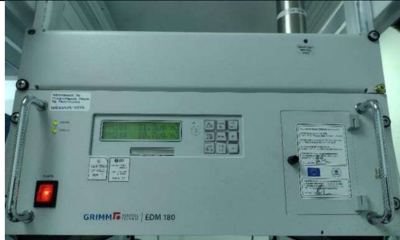
Figura 10. Monitor y Soporte instalado en Rack 19"
