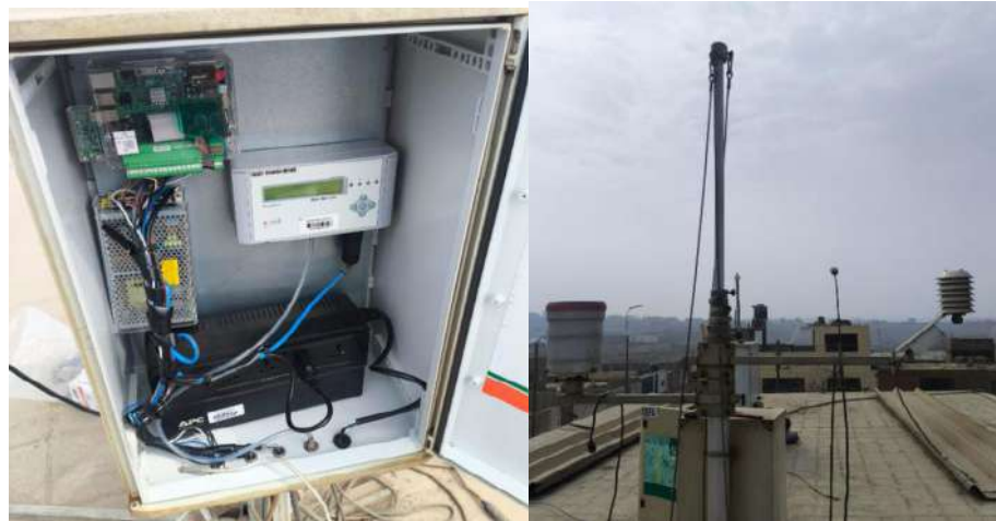
Figura 12. Conexión de cables al UPS
