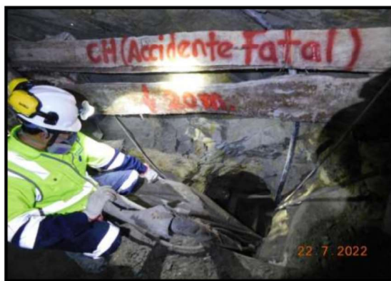
Fotografía N° 12: Vista del acceso a la Chimenea Vertical desde la labor 2N (Segundo Nivel), el cual conduce hacia la labor 3N (Accidente Mortal), donde se observa que no tiene condiciones de accesibilidad (sección reducida) para un ingreso adecuado de personas. Asimismo, se evidenció que no tiene letrero visible en el acceso a la chimenea vertical.
