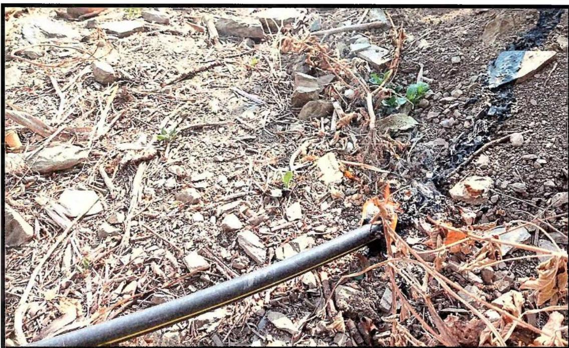
**Foto 10:** Afectación de incendio en tuberías de redes de riego tecnificado en el Sector de San Pedro – Caldera.
