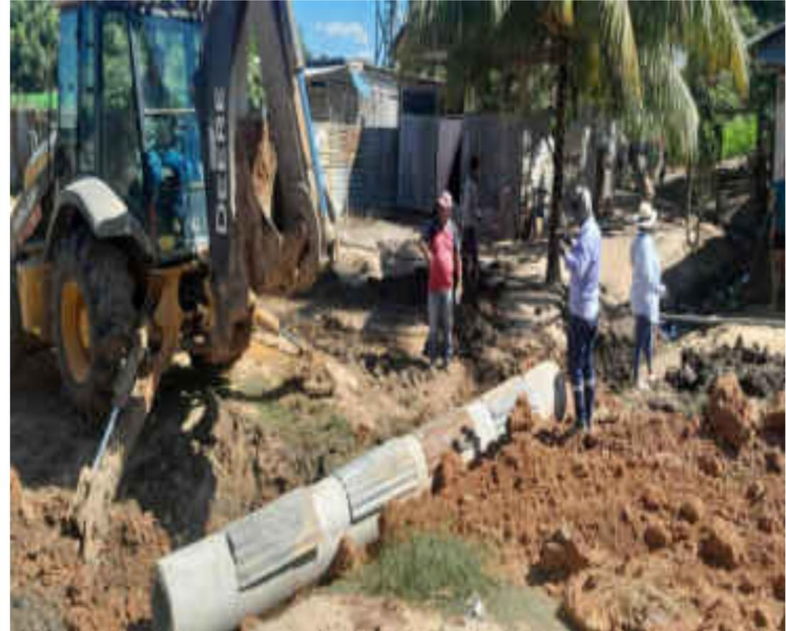
**Se Aprecia los Trabajos colocación de tubos de concreto el cual fue mejorado para pase de agua**
