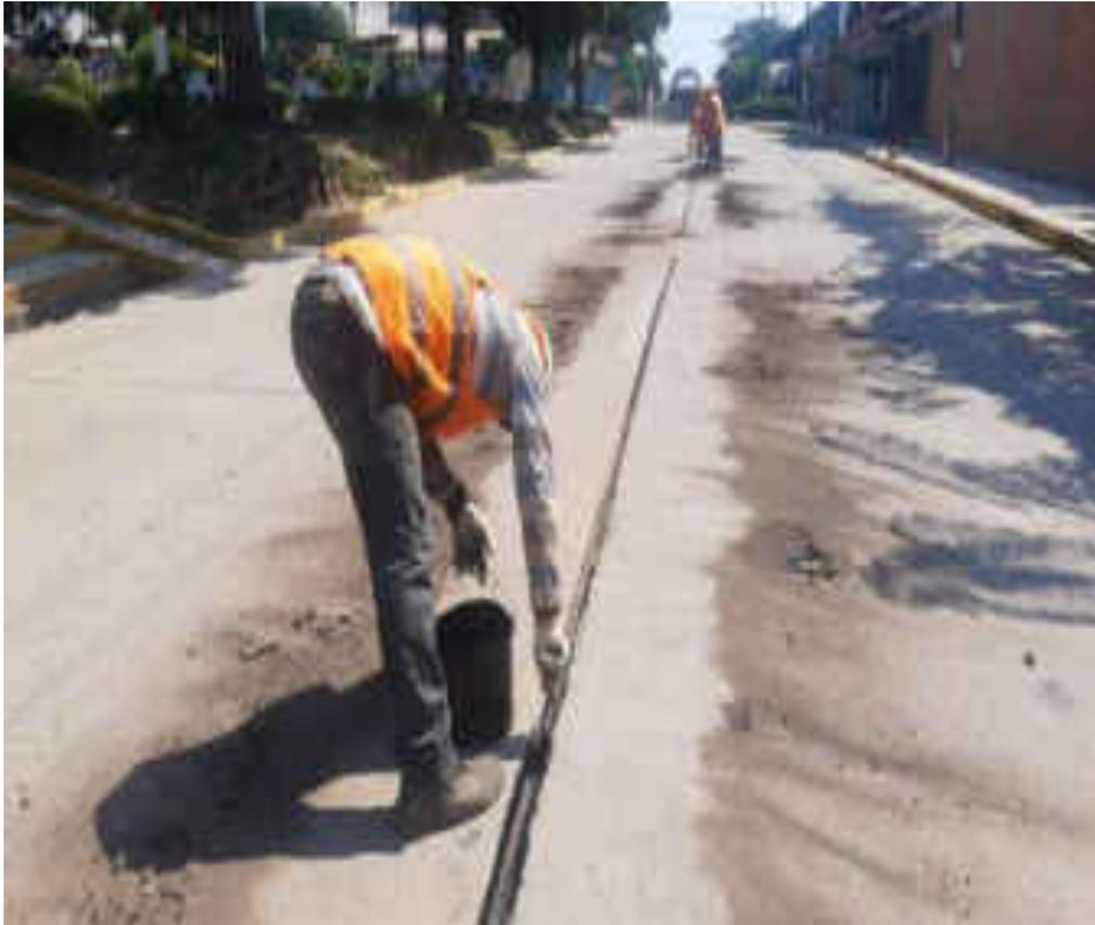
**Se Aprecia los Trabajos de impermeabilización en juntas**
