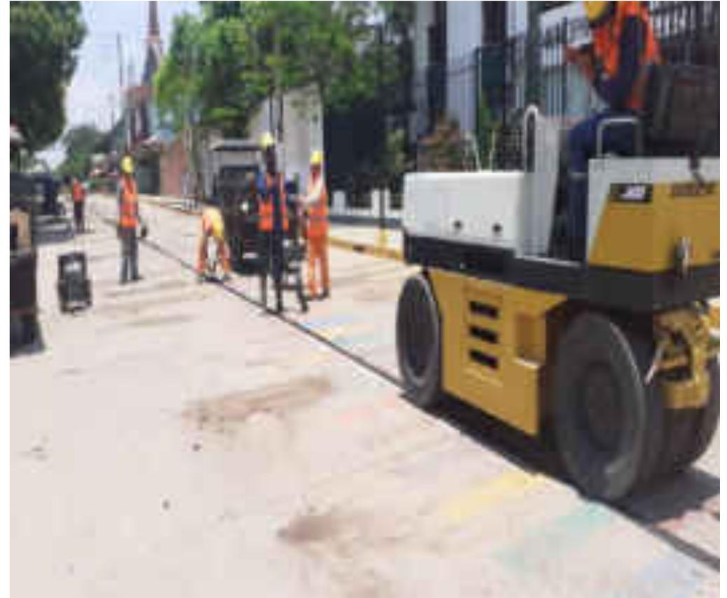
**Se Aprecia los Trabajos de compactación con maquinaria en juntas**
