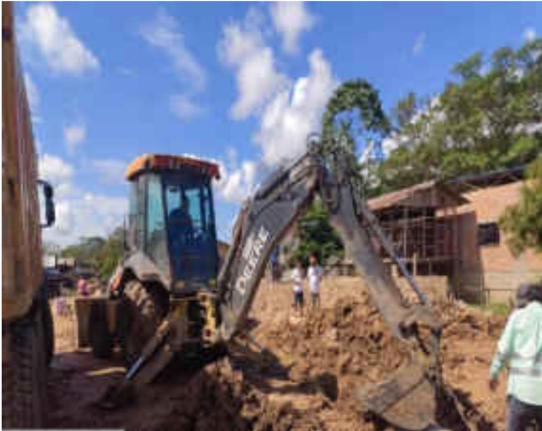
Se Aprecia los trabajos de excavación para la colocacion de tubos de concreto
