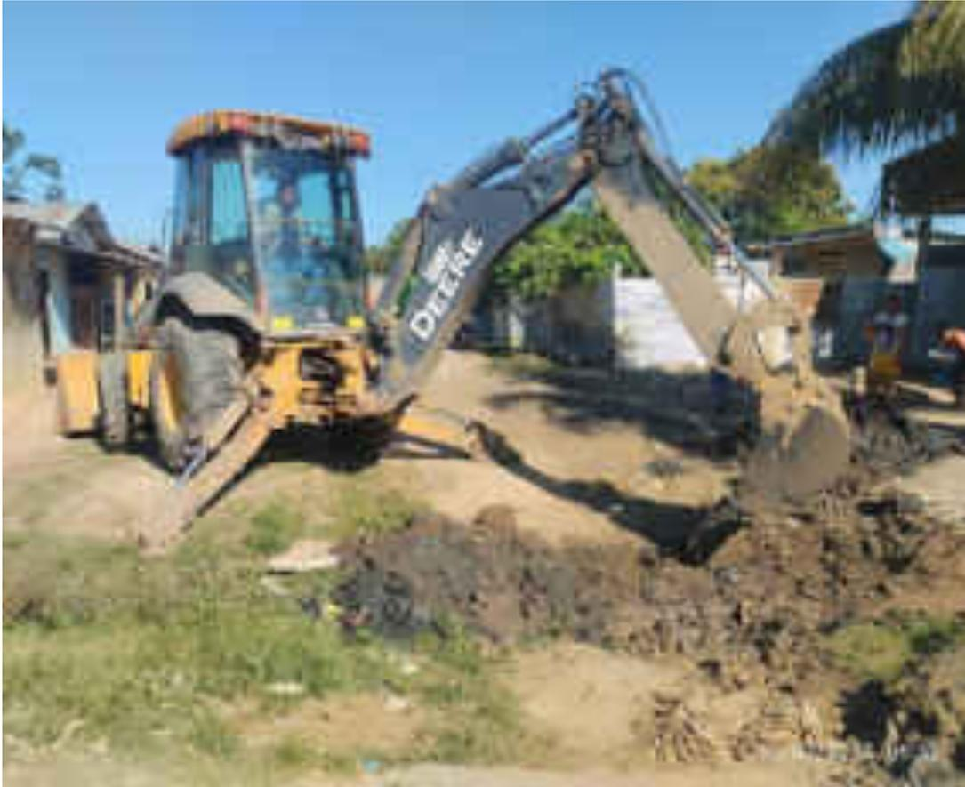
**Se Aprecia los trabajos de excavación para la colocación de tubos de concreto**
