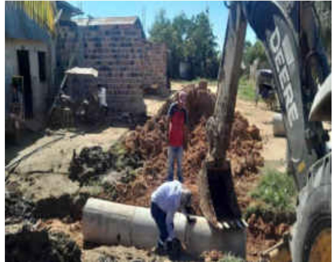
**Se Aprecia los Trabajos de colocación de tubos de concreto para pase de agua**
