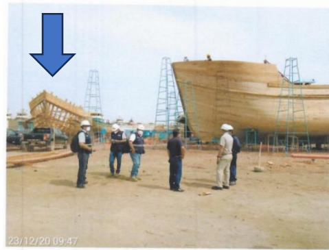
Fotografía N° 03. Fiscales de la DGSFS-PA del Ministerio de la Producción, personal de la Dirección de Capitanías y Guardacostas -Chimbote y representantes del astillero LUGUENSI E.I.R.L., evidenciando la construcción de una segunda EP artesanal y la primera EP de mayor escala, con un avance de 30% y 60% respectivamente, el día 23/12/2020.
