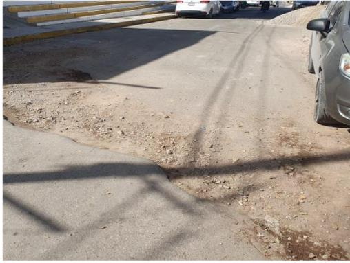
Fig.1: Fallas estructurales en el pavimento existente
