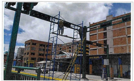
Trabajos de instalación de semáforos, prog. 4+000 - Costanera I.
