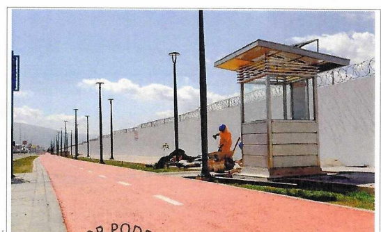
Acabado en bases de casetas de vigilancia.
