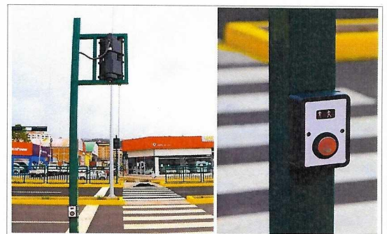
Instalación de los controles de excepción para cruces peatonales.
