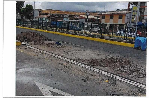
Instalación de monoblock, prog. 4+500.
