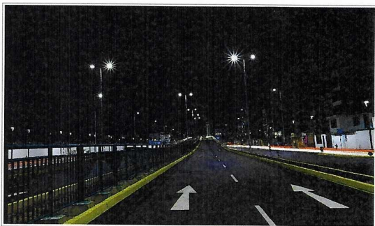
Iluminación vial y peatonal.
