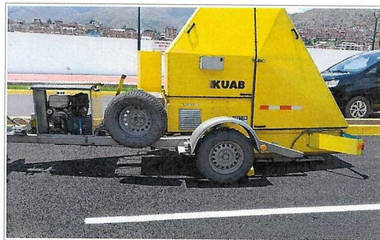
Prueba de deflexión de la carpeta asfáltica con Deflectómetro de impacto.
