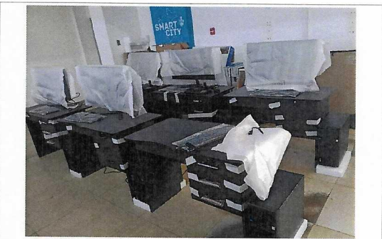
Instalación de terminales en el centro de control semafórico.
