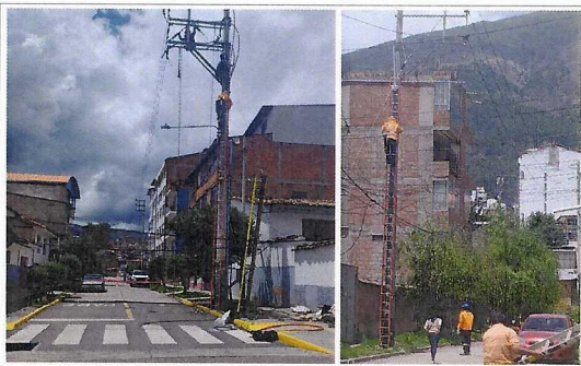
Revisión para restituir el servicio de alimentador QU-03. Retirando la puesta a tierra temporal.
