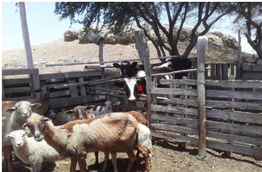
Foto 7: Vista en detalle de la afectación 4 (corrales para crianza de animales domésticos) y el continuo deterioro de la edificación con adobes de la huaca por la fuerte humedad y sales activas que genera dicho factor antrópico.
