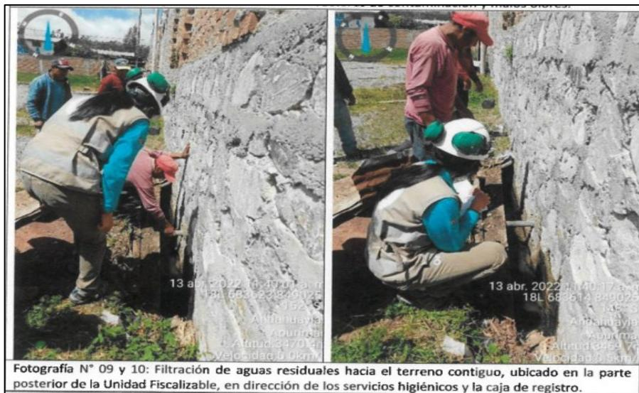
Fotografía N° 09 y 10: Filtración de aguas residuales hacia el terreno contiguo, ubicado en la parte posterior de la Unidad Fiscalizable, en dirección de los servicios higiénicos y la caja de registro.
