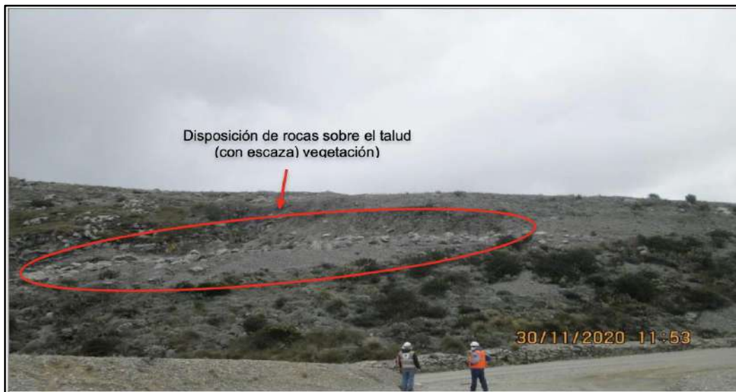
Fotografía N° 26. Durante la acción de supervisión noviembre-diciembre 2020, se verificó que dicho depósito se encontraba ubicado adyacente a la Cantera China Linda Este, georreferenciado en la coordenada UTM WGS 84 Zona 17 N: 9234033, E: 780639 y altitud de 4019 m.s.n.m. En el depósito de desmonte de finos se verificó la disposición de material grueso sobre el talud de dicho depósito que presentaba escasa vegetación que habría brotado de manera natural. 58
