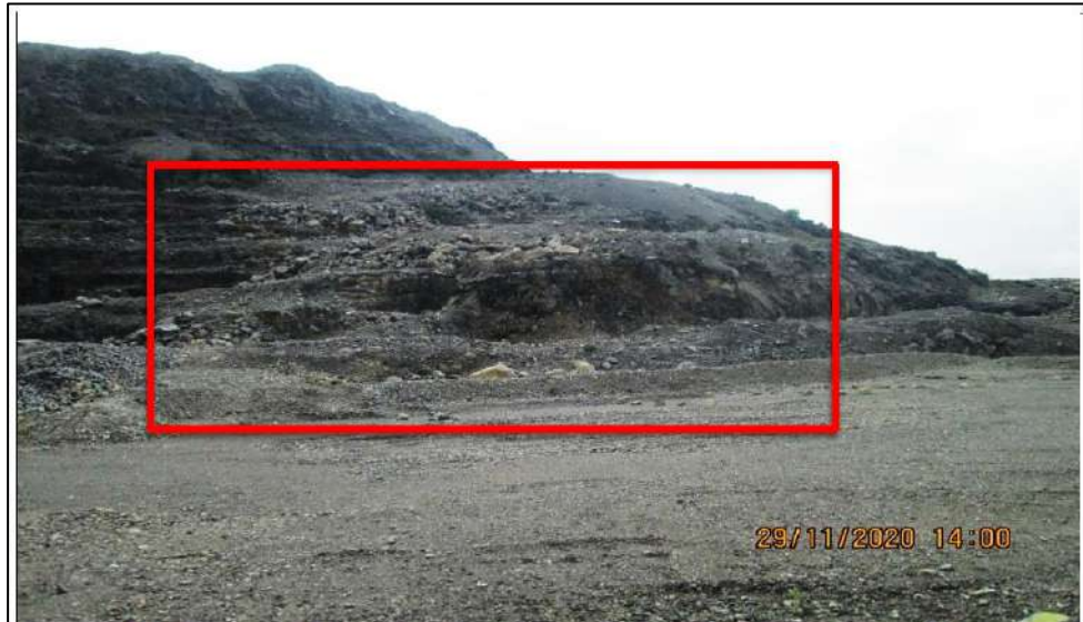
Fotografía N° 1. En la cantera China Linda Este se observó que los taludes de los bancos se encontraban erosionados. 16
