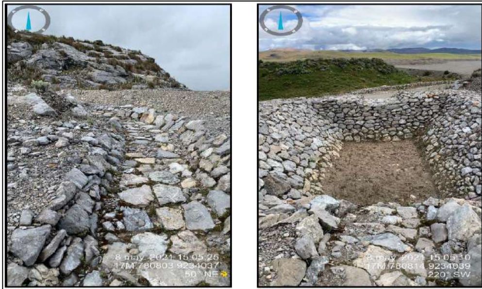
Fotografías N°8 y N°9: Limpieza y mantenimiento de sistema de drenaje
