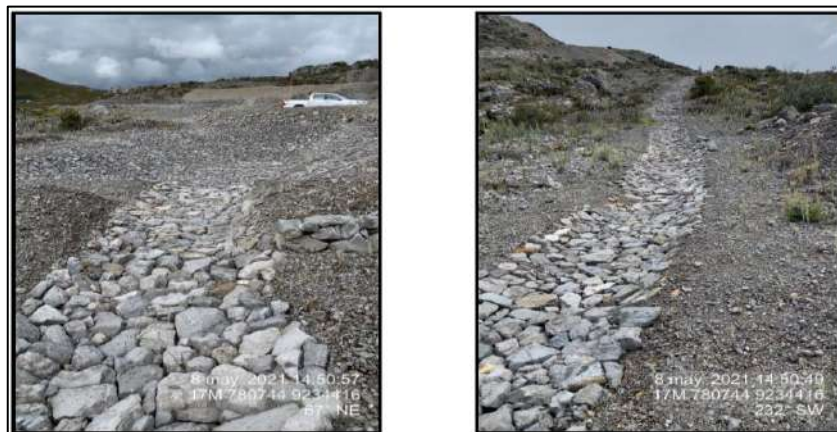
Fotografías N°1 y N°2: Limpieza y mantenimiento de sistema de drenaje
