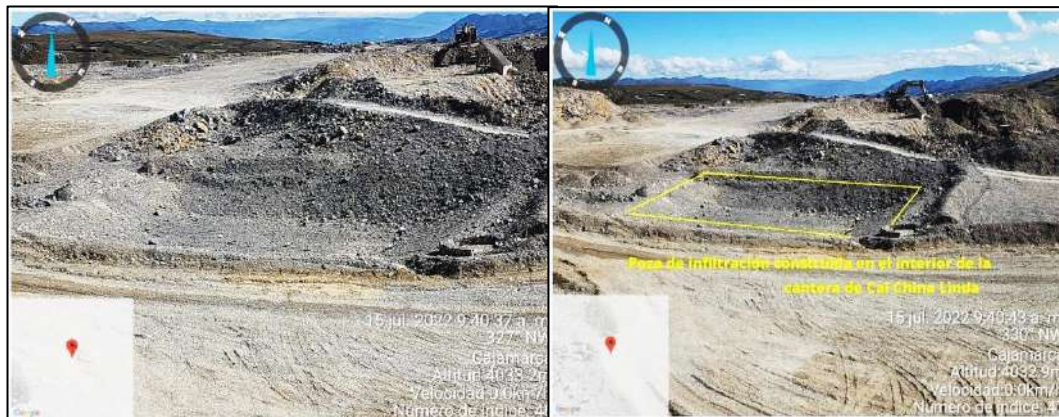
Fotografías N°16 y N°17: Pozo de infiltración construido en el interior de la Cantera de Cal China Linda
