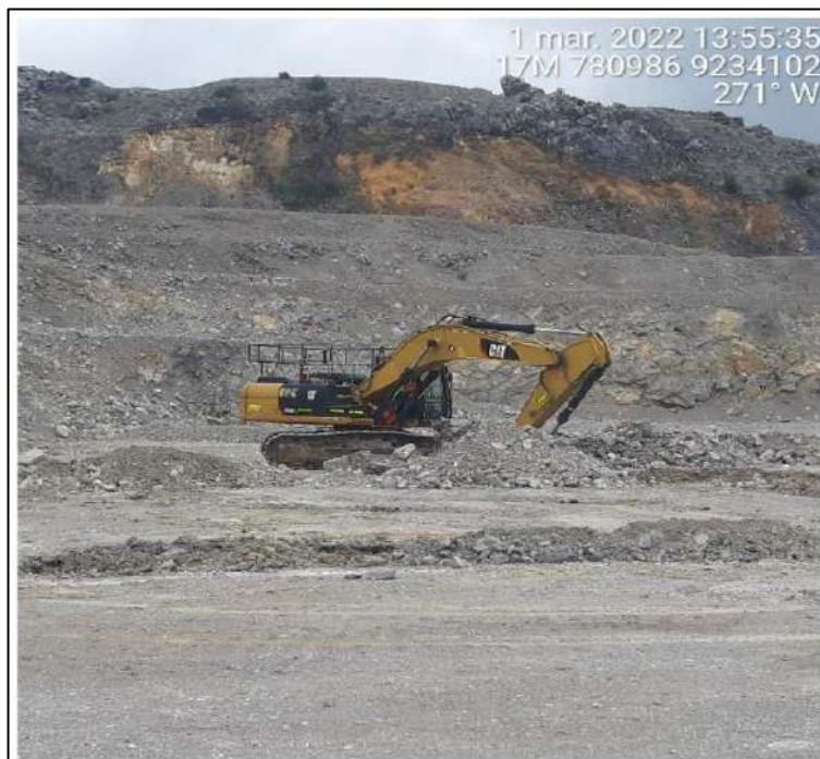
Fotografía N°11: Construcción de poza de infiltración en el interior de la Cantera de Cal China Linda
