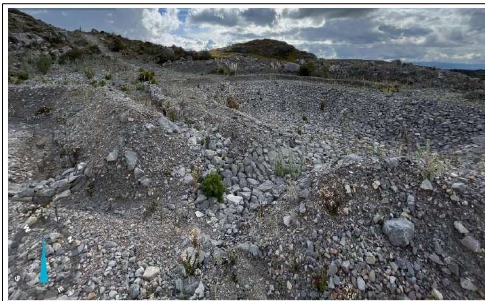
Fotografía N°3: Mantenimiento del sistema de drenaje en cantera China Linda Canal y poza de sedimentación
