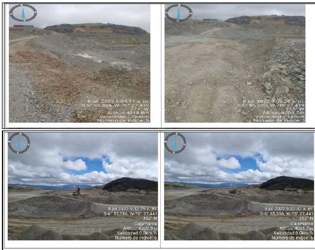
Fotografías N°12, N°13, N°14 y N°15: Vistas de poza de infiltración construida en el interior de la Cantera de Cal China Linda
