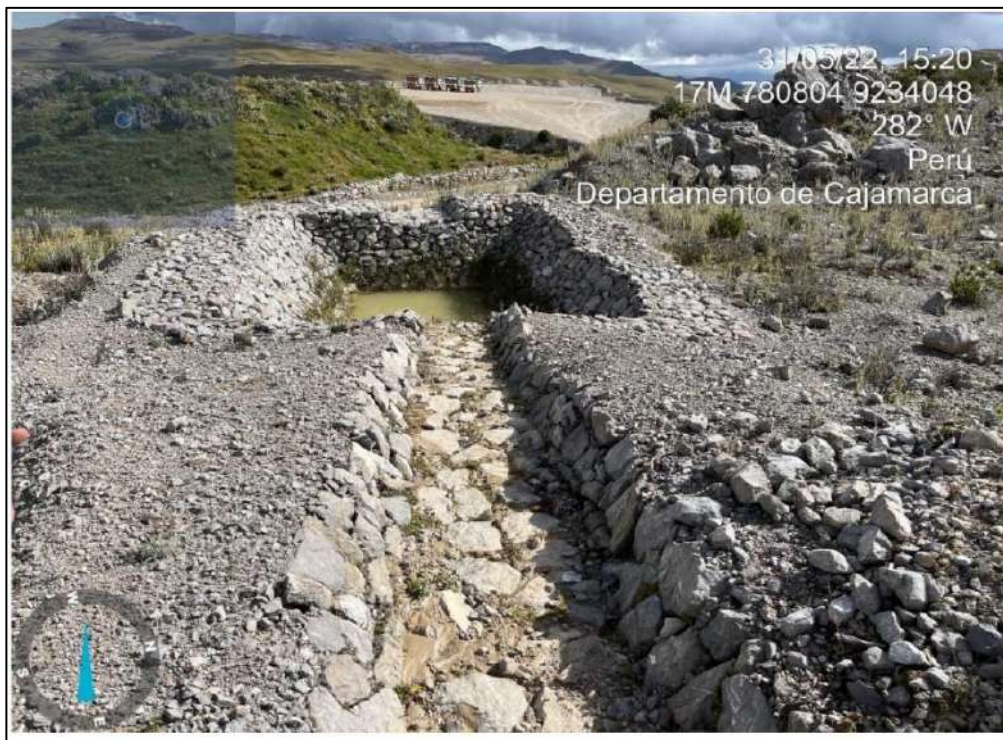
Fotografía N°10: Direccionamiento de agua de escorrentía hacia poza de sedimentación
