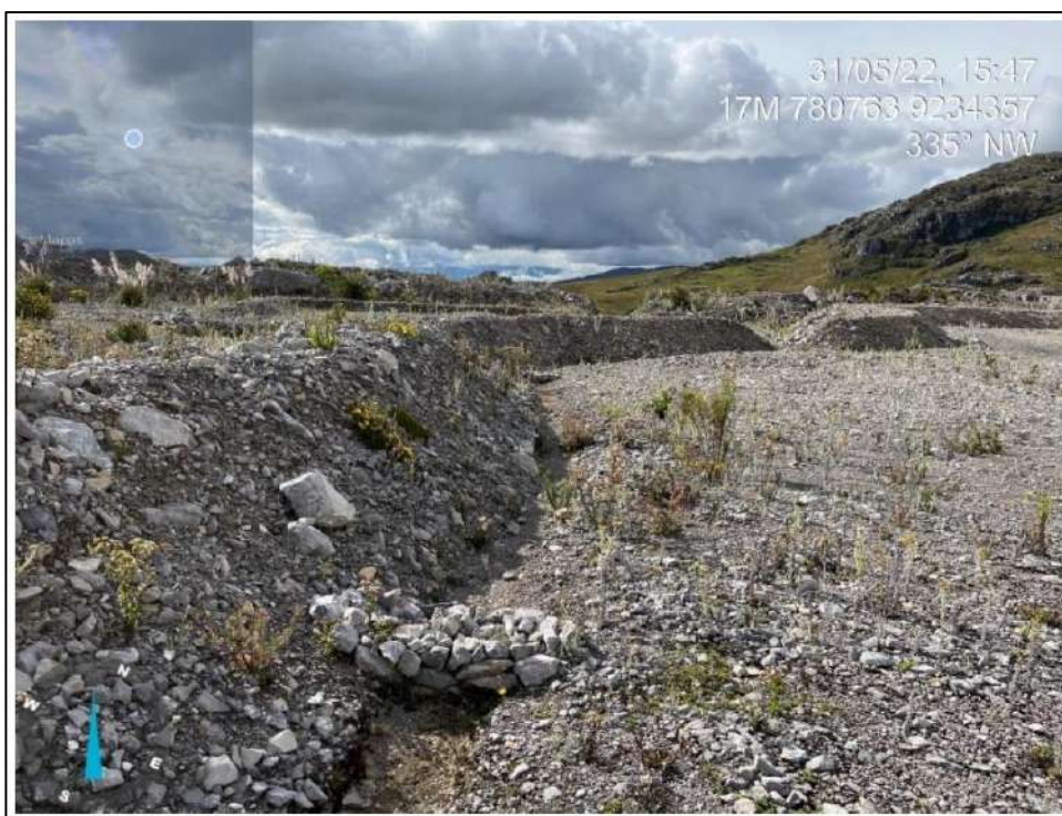
Fotografía N°4: Implementación de check dams para direccionamiento de aguas
