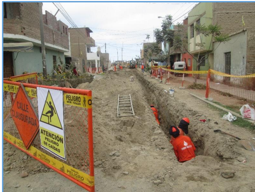
REHABILITACION DE CONEXIONES DOMICILIARIAS DE AGUA POTABLE
