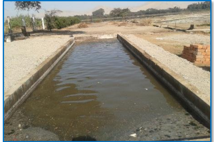
DESARENADORES DE LA LAGUNA DE OXIDACION DE CACHICHE
