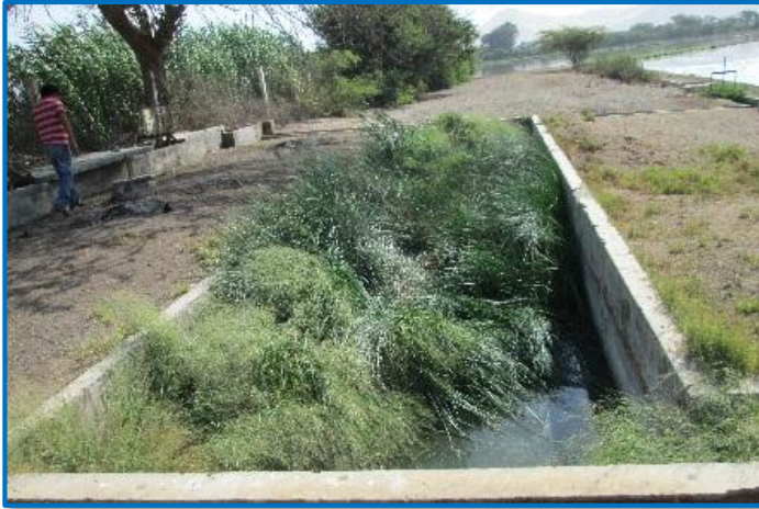
DESARENADORES DE LA LAGUNA DE OXIDACION DE CACHICHE
