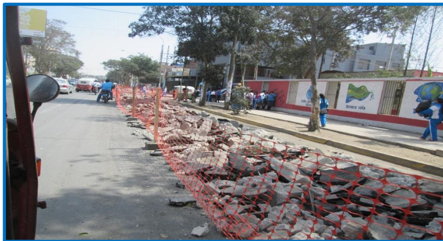
RENOVACION DE REDES - OBRA FINANCIADA POR LA MUNICIPALIDAD DE ICA - AV. MATIAS MANZANILLA
