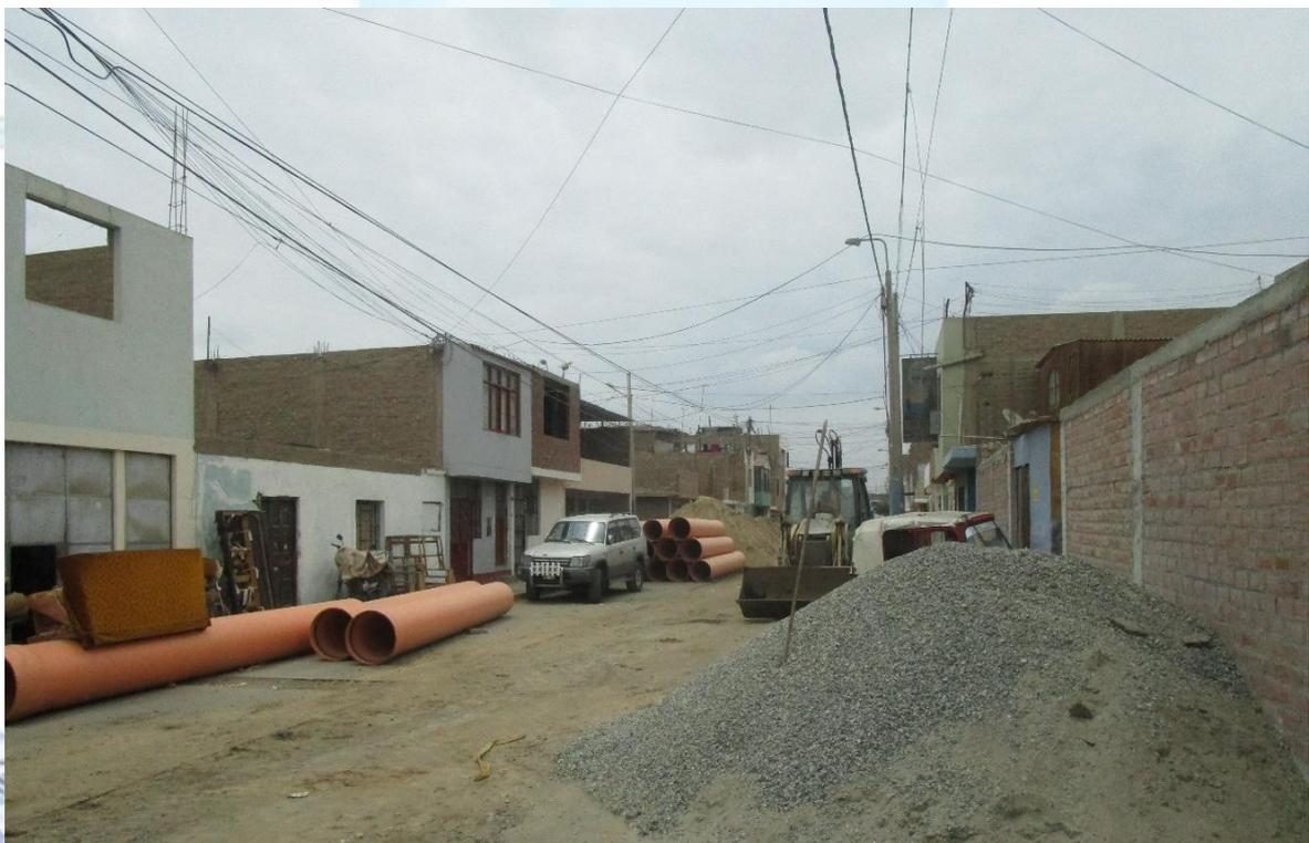
Renovación de tuberías de asbesto-cemento por PVC ISO 4416 de mayor calidad y garantía.
