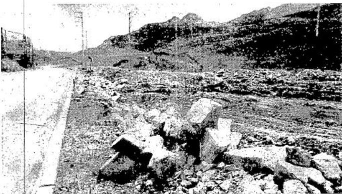
Foto 6. Muestra de los restos de pavimento demolidos por la presencia de fisuras en el proceso de recepción de obra y que fueron observados por el comité de recepción de obra, los cuales yacen a un costado de la vía.
