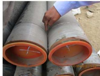
Foto 2. Durante la visita realizada el 11-09-2018 al proyecto "Derivación a ERP Punta Hermosa", en el Pk 2+070.00, cerca al ingreso de la futura ERP, en la vía auxiliar de la Av. Panamericana Sur, se tenía apilada tubería Ø 8" X52 y tubería Ø 8" X42 y se observa que no están separadas había contacto entre ellas, no se tenía un elemento distanciador.
