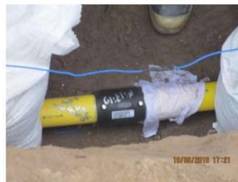
Foto 2. Durante la visita realizada el 19-06-2018 al proyecto "Ext. Red a Arteco-Proy. Los Faisanes Cho-Sector 1200-Malla 00" se estaba realizando trabajos de electrofusión para la unión o "pega" # 49 de tubería de PE Ø 63 mm y no se usó alineador, el fusionista utilizó sacos de arena para "fijar" la tubería. Se muestra la unión en tiempo de entriamiento.
