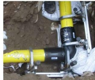
Foto 2. Durante la visita realizada el 15-06-2018 al proyecto "Ext. Red a Av. Paseo de La República 6240 – MR, Sector 1400 Mallas 00, 06", se ejecutaban trabajos de electrofusión de las "pegas" W 6616 y W 6615 en un codo de 90° de PE D 110 mm. No se tenía la herramienta apropiada, es decir un alineador de 90° para unir los extremos de los codos con la tubería. Se colocó alineadores individuales y no un sistema acoplado a 90°.
