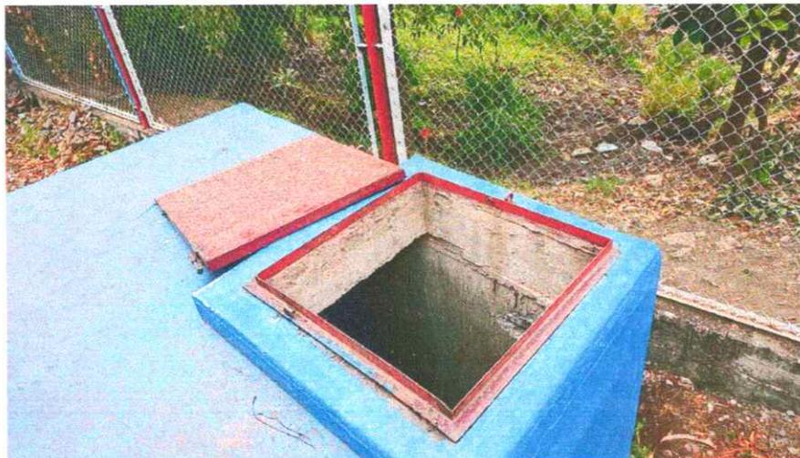
TAPA SANITARIA (CAJA DE VÁLVULAS). - 01 tapa sanitaria de 0.40m x 0.40 m Evidencia daños, es necesario su reemplazo. Ver imagen adjunta
