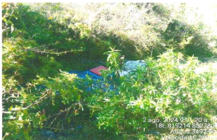
*ZANJA DE CORONACIÓN. - No tiene zanja de coronación, requiere de 20m de zanja de coronación, porque en la captación hay presencia de agua superficial. Esta actividad será aporte comunal. Ver imagen adjunta.*
