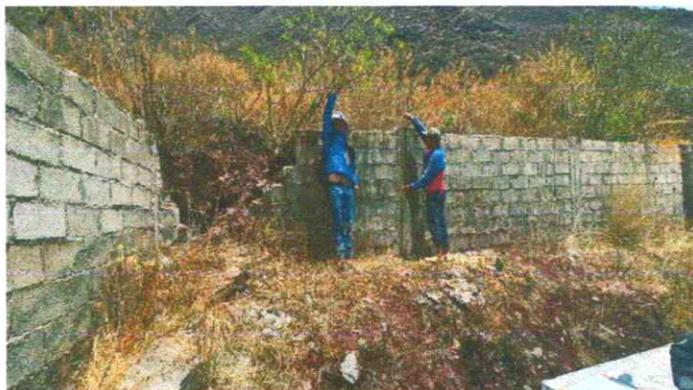
RESERVORIO. – como se ve el cerco perimétrico del reservorio está colapsado por un parte y por el cual se debe realizar el mantenimiento con una intervención de nuevo muro.
