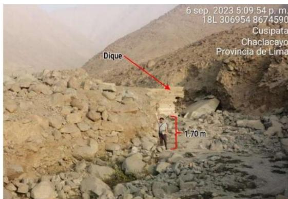
Figura N°03: Socavación del flujo de detritos en calle las Terrazas, Cusipata(8)
