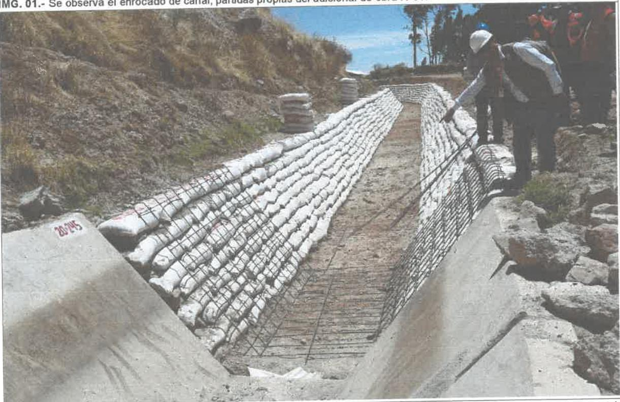
IMG. 02.- Se observa la disposición de sacos de polipropileno relleno con material afirmado. En diversos tramos a lo largo del canal. Partida propia del Adicional de obra N°01.
