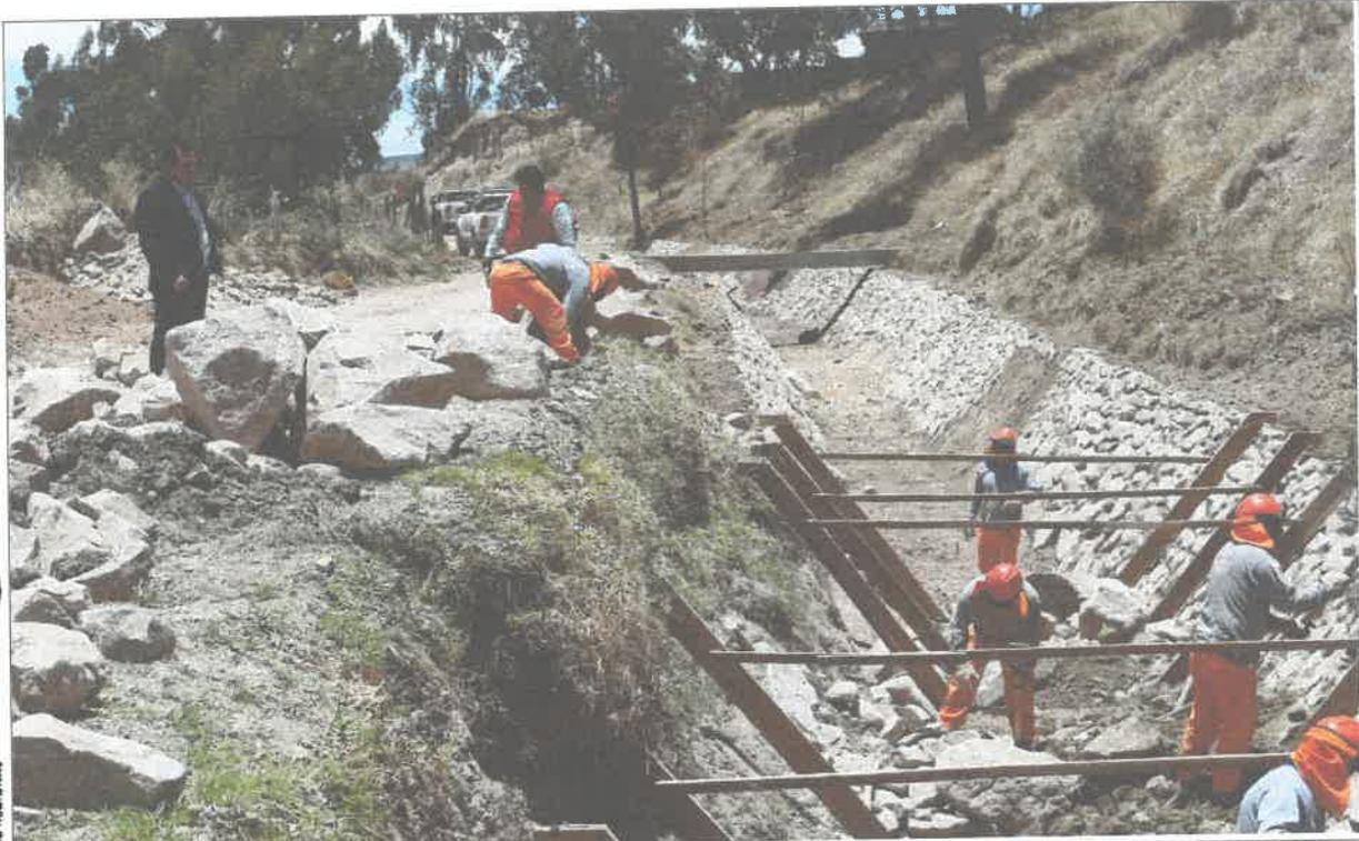
IMG. 01.- Se observa el enrocado de canal, partidas propias del adicional de obra N°01.
