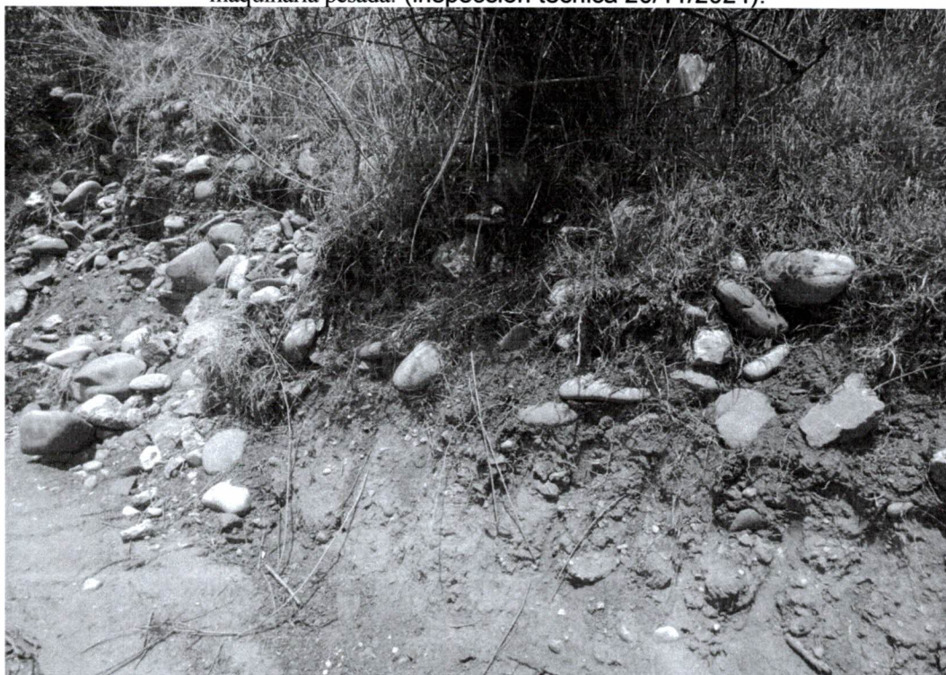
Foto.2: Vista del corte del perfil con relleno cultural, donde se evidencia rastros de la maquinaria pesada. (inspección técnica 20/11/2024).
