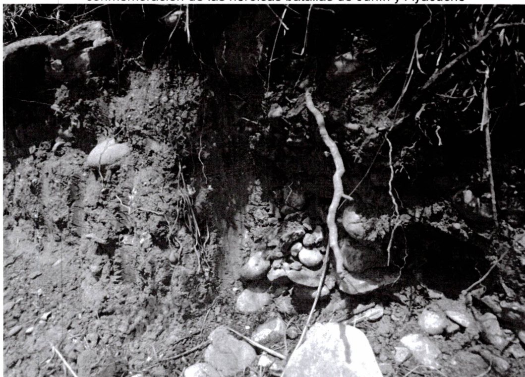
Foto.3: Vista del corte del perfil con relleno cultural, donde se evidencia rastros de la maquinaria pesada. (inspección técnica 20/11/2024).
