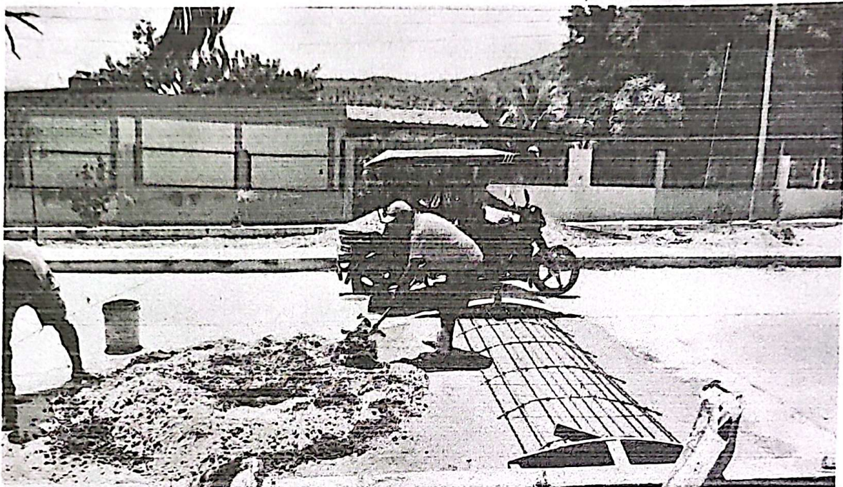
Descripción: Armado de malla de fierro y preparación de mezcla de concreto.
