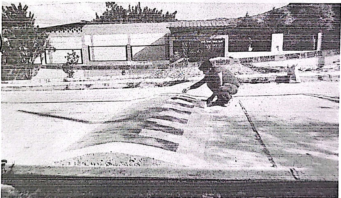
Descripción: Pintado de estructura para señalización.
