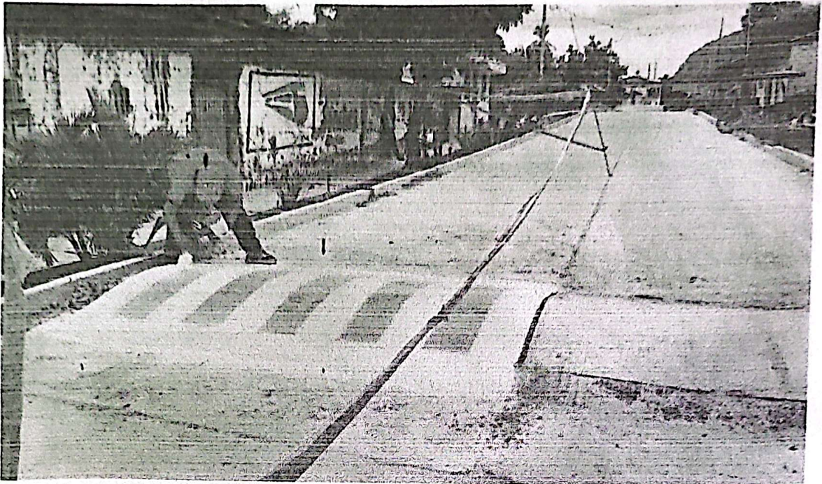
Descripción: Pintado de estructura para señalización.
